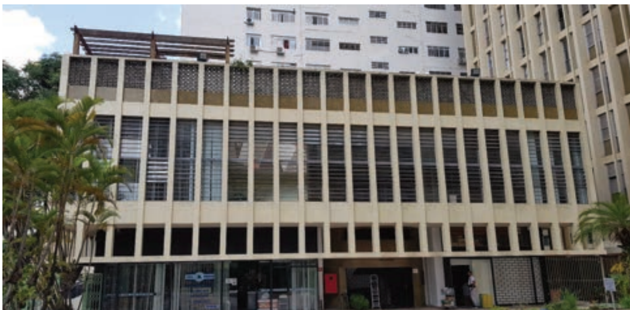
Foto 6 – Prédio do Salão de Festas com Piscina e Playground no terraço
