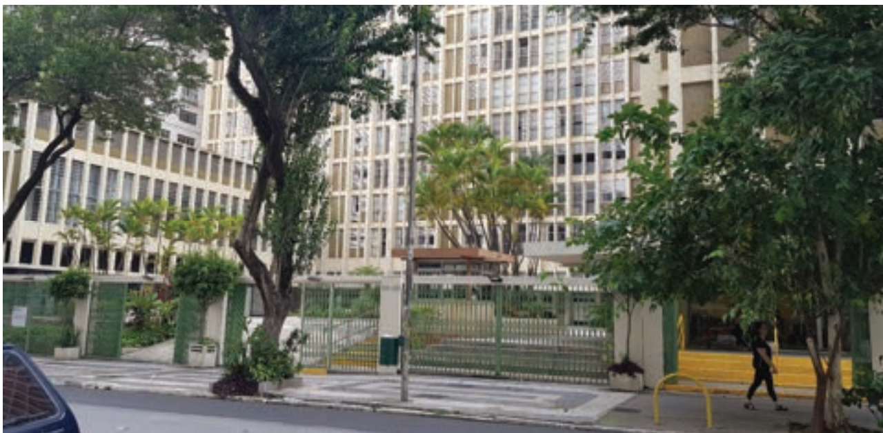
Foto 1 – Vista da fachada do Condomínio e do Bloco A1 onde está localizado o imóvel avaliando
