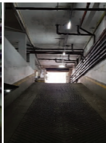
Foto 19 – Rampa de acesso à saída
