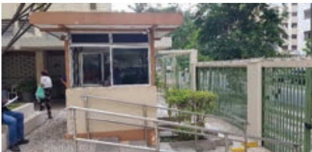
Foto 2 – Vista da portaria, portões e guarita
