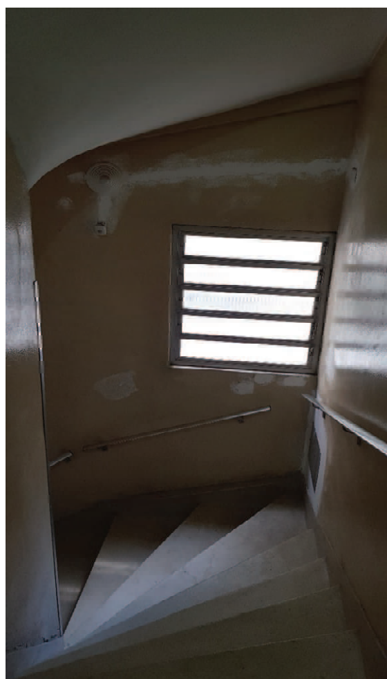
Foto 13 – Vista da escada do 3º pavimento
