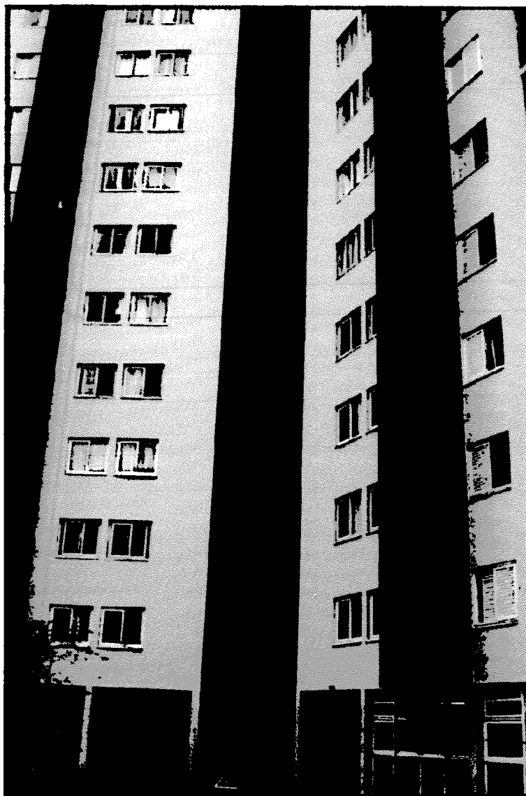
FOTO nº 04 Vista da fachada frontal do Bloco - 1.
