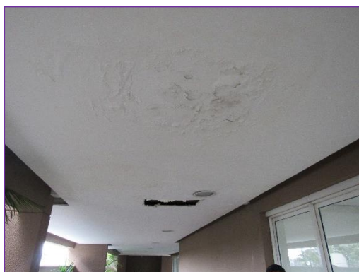
Projeção das infiltrações provenientes do apto. nº 13 na circulação do térreo.
