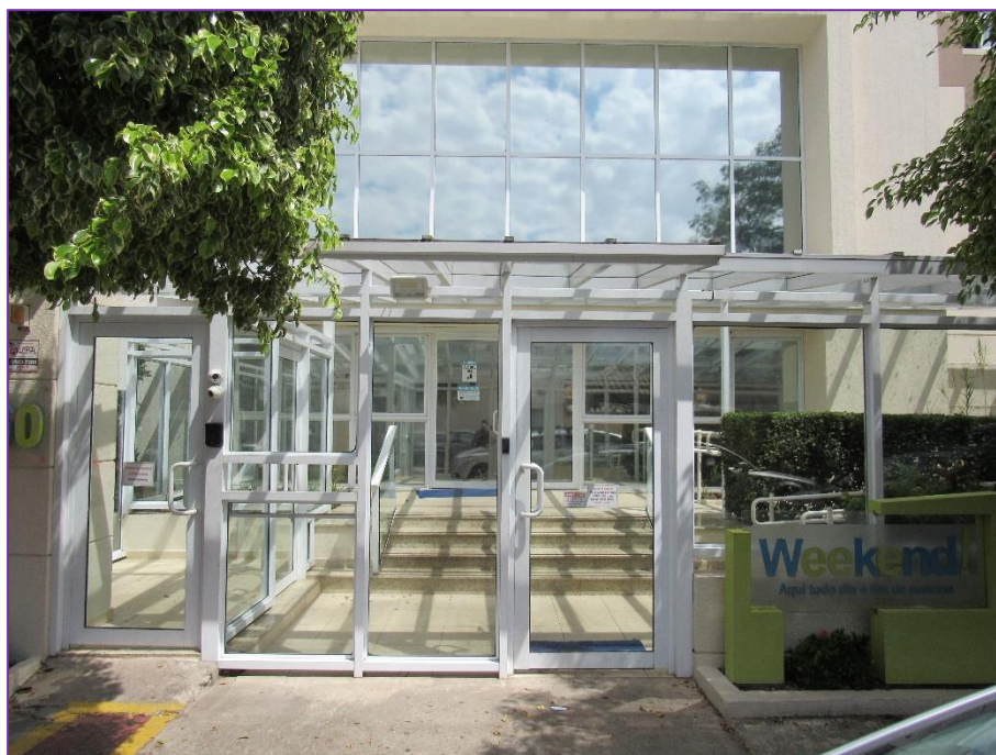
Acesso a portaria.
