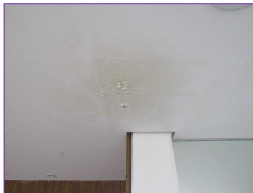
Projeção das infiltrações provenientes do apto. nº 13 na circulação do térreo.
