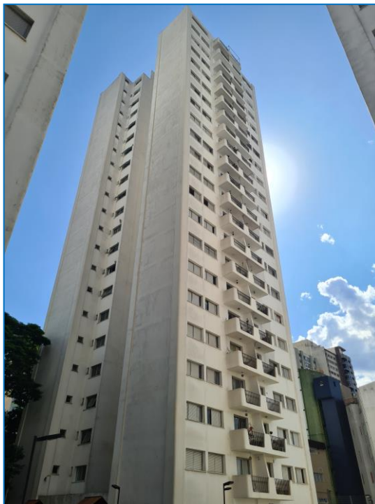
Foto de nº 42 - Fachada do Edifício Sobralia – Bloco II.
