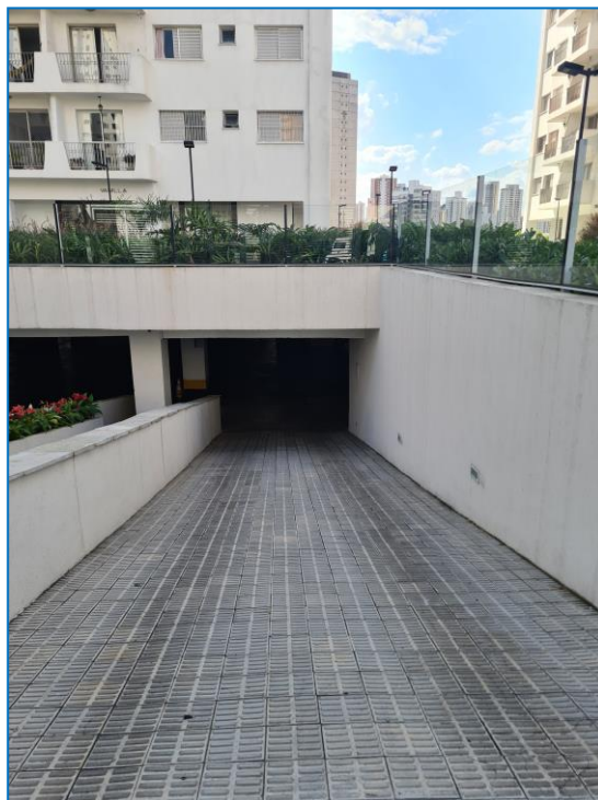
Foto de nº 11 - Sistema viário / rampa de acesso.
