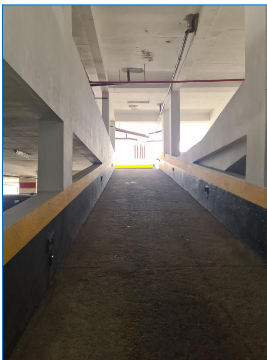
Foto de nº 17 - Sistema viário / rampa de acesso.
