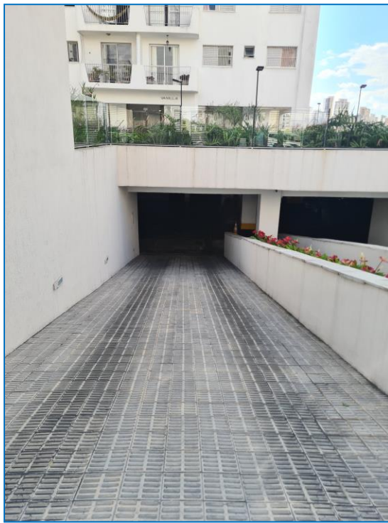
Foto de nº 10 - Sistema viário / rampa de acesso.
