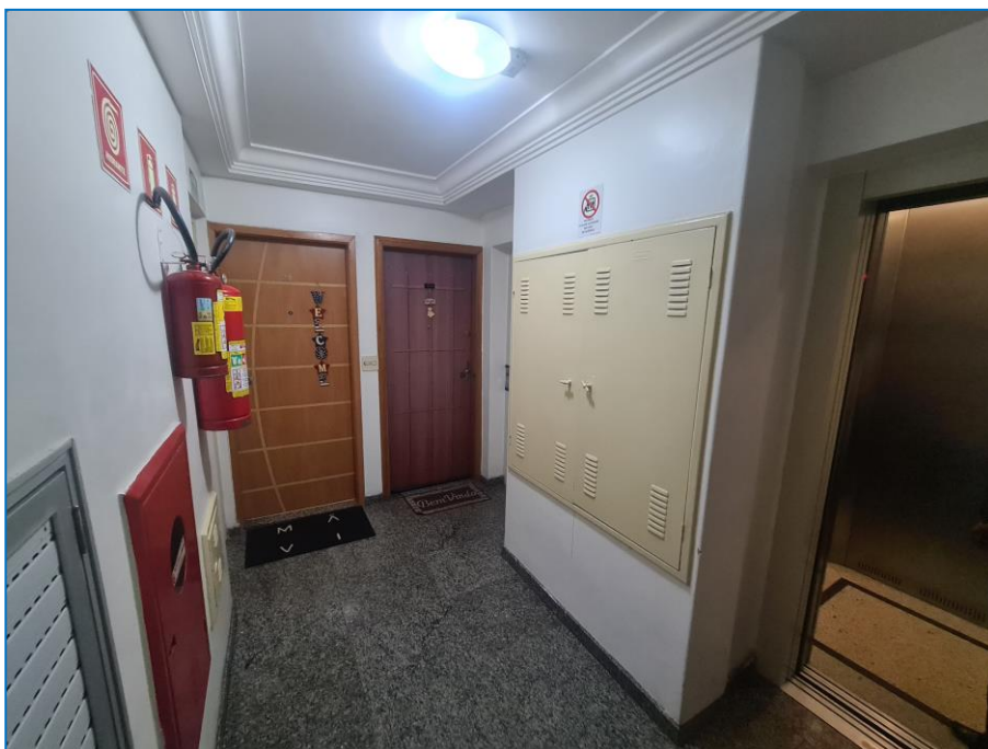
Foto de nº 48- Hall dos elevadores no 2º andar.
