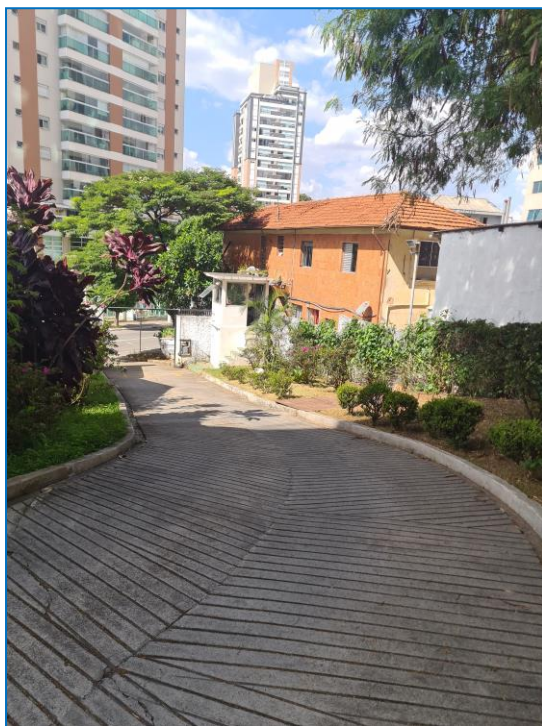
Foto de nº 23 - Sistema viário / rampa de saída para a Rua José Debieux.
