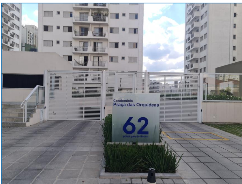
ACESSO DE VEÍCULOS.
