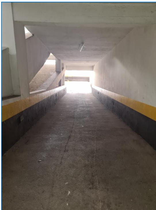
Foto de nº 16 - Sistema viário / rampa de acesso.
