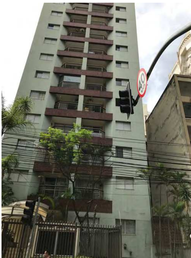
Foto 1- Vista do Ed. Quartier Latim onde está inserido o imóvel avaliando.
