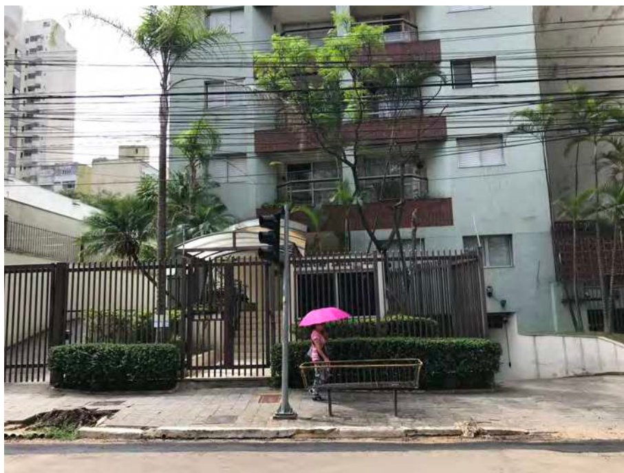
Foto 2- Vista do Terreo com as entradas para garagem e guarita.
