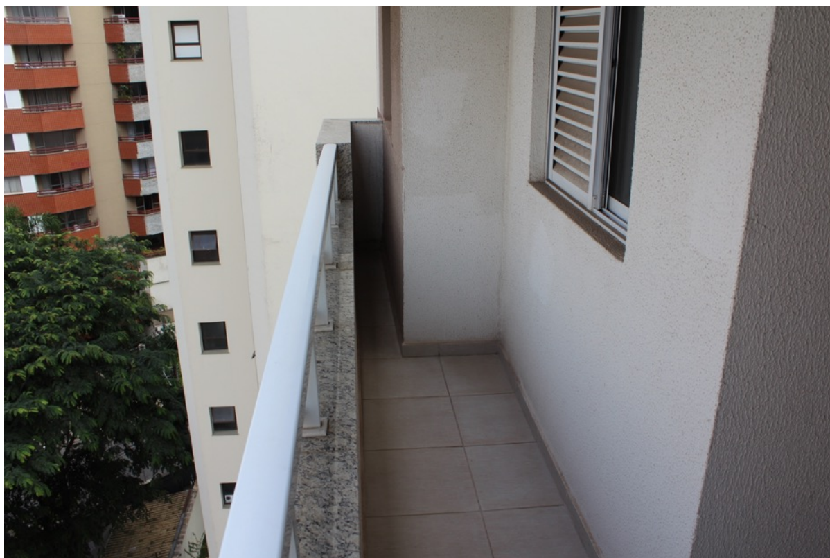
Apartamento Nº 94 – Varanda
