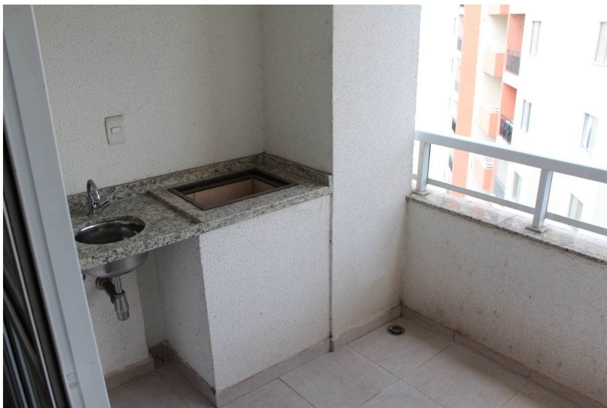
Apartamento Nº 94 – Varanda
