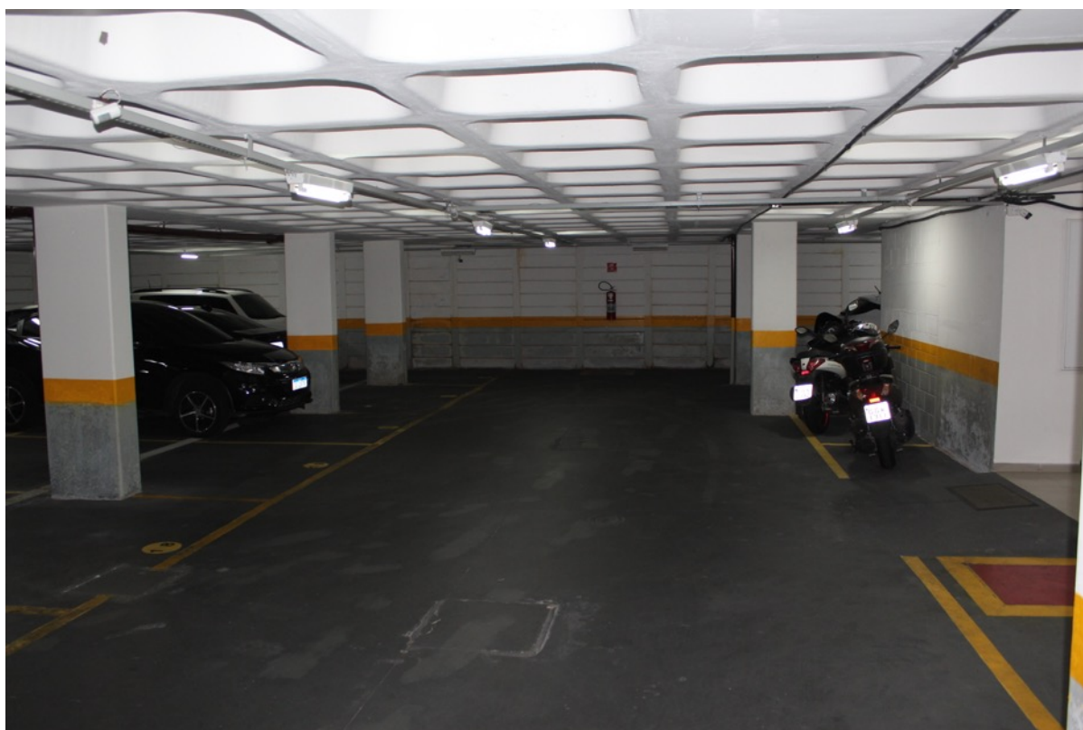
Condomínio Quality Place - Estacionamento
