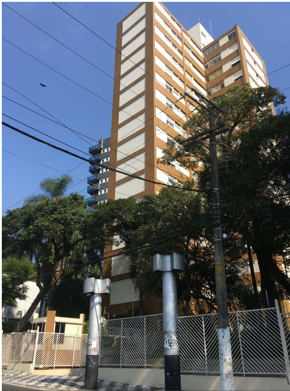
ASPECTOS GERAIS FACHADA - CONDOMINIO
