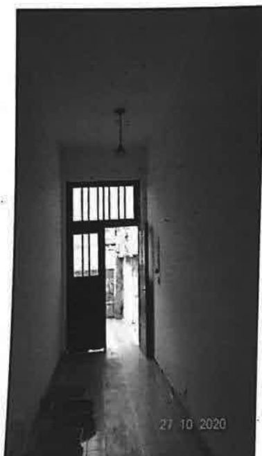
FOTO 14: Vista da área de serviço da edificação. Observa-se umidade/fungos e fissuras na alvenaria e na laje.
