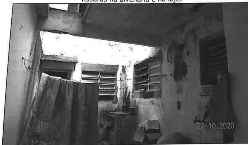
FOTO 14: Vista da área de serviço da edificação. Observa-se umidade/fungos e fissuras na alvenaria e na laje.
