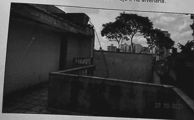
FOTO 31: Vista da área externa da unidade avalianda. Nota-se manchas de umidade/fungos e fissuras na laje e na alvenaria.
