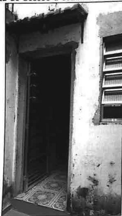
FOTO 15: Vista do acesso a cozinha da unidade avalianda.
