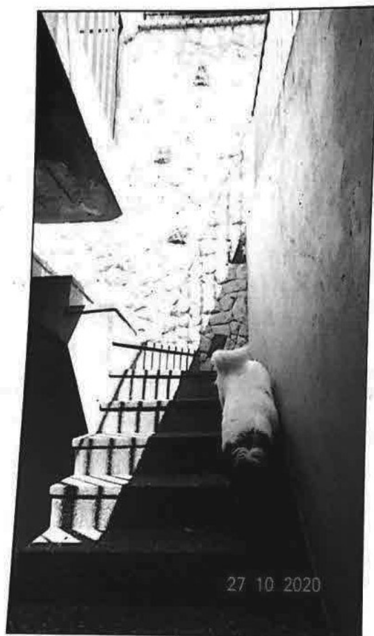
FOTO 06: Vista do acesso a unidade avalianda.
