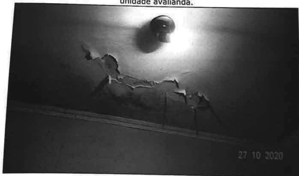
FOTO 20: Vista da umidade presente na laje de cobertura do banheiro da unidade avalianda.
