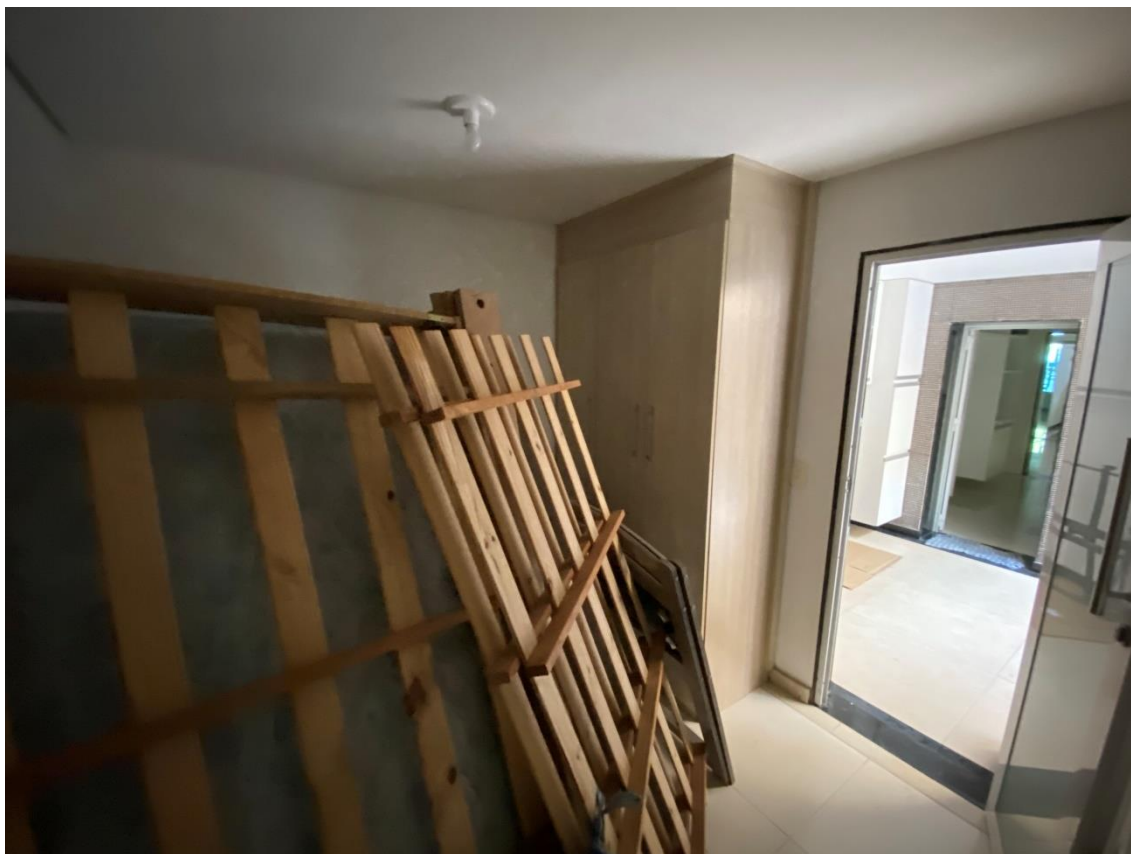
Foto 15: Vista da suíte de serviço.
