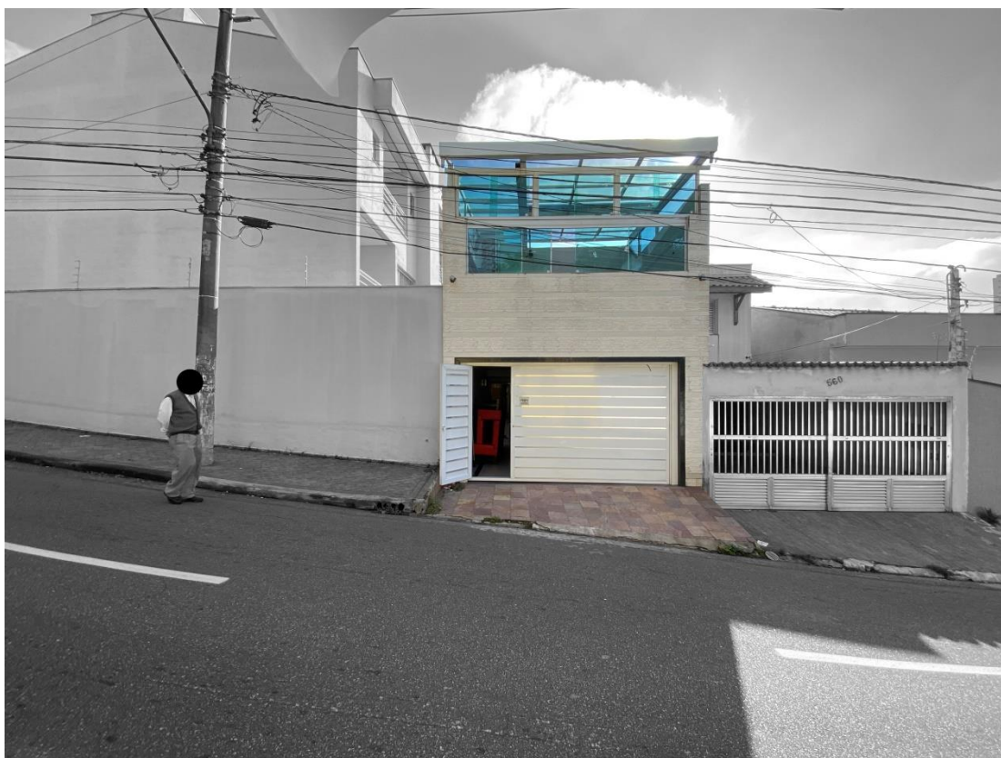
Foto 01: Vista da fachada desde Rua Princesa Francisca Carolina.
