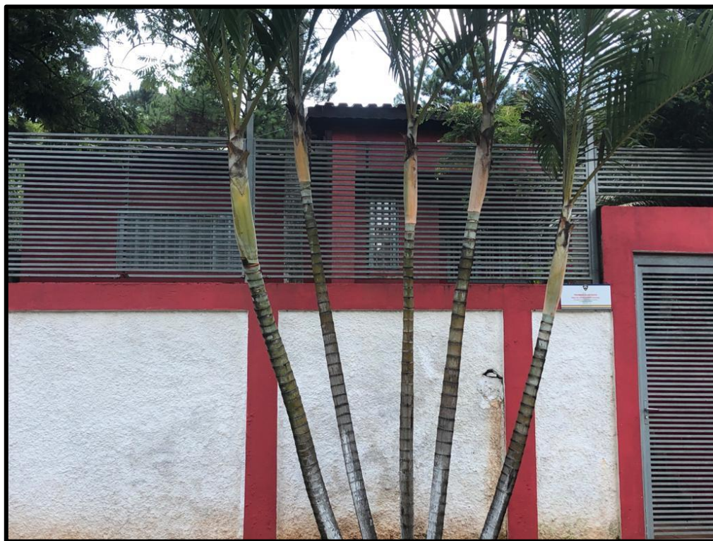
Foto 3: Vista do imóvel
