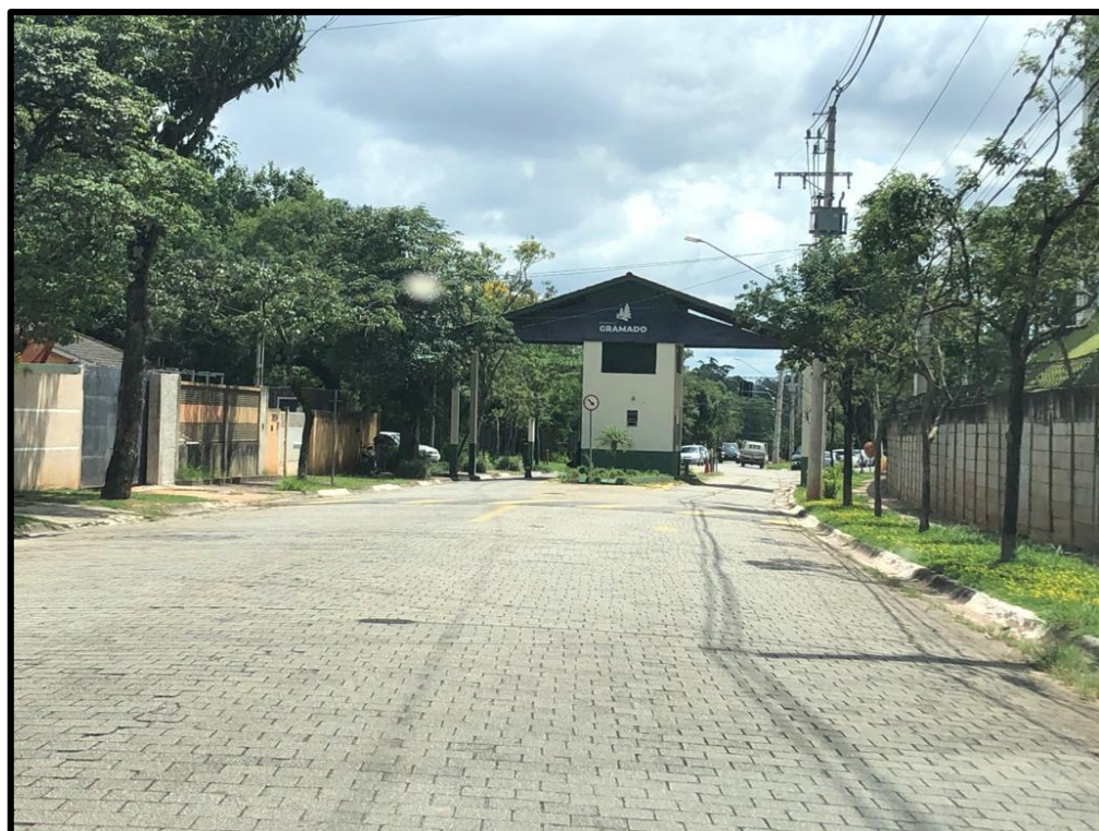
Foto 8: Portaria principal do Loteamento Gramado
