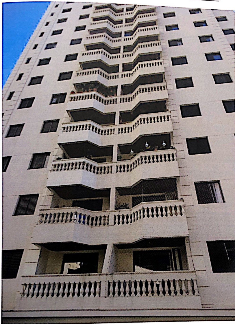
FACHADA DE FUNDOS DO PRÉDIO
