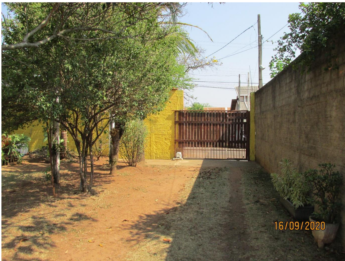
Área Descoberta III/Portão Eletrônico (Entrada e Saída)
