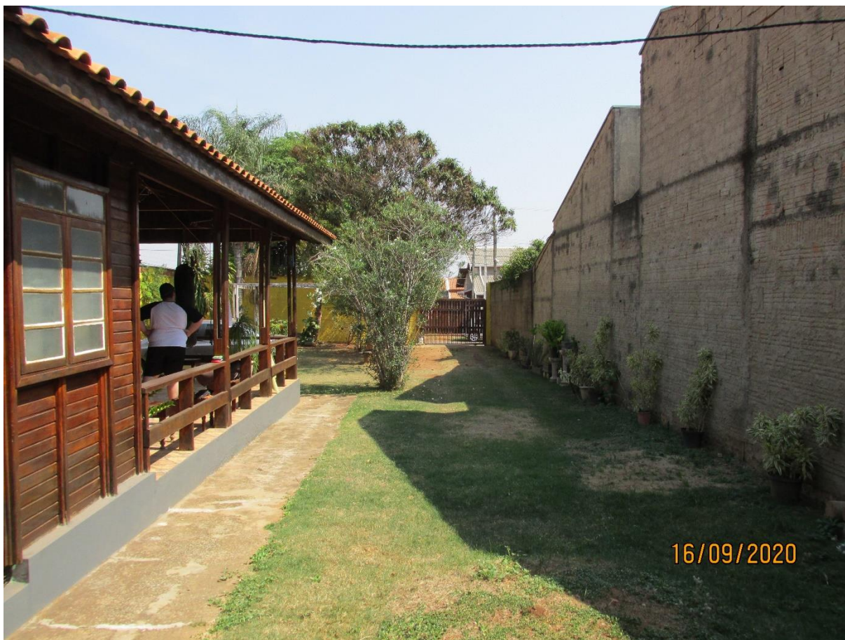
Área Descoberta Lateral II
