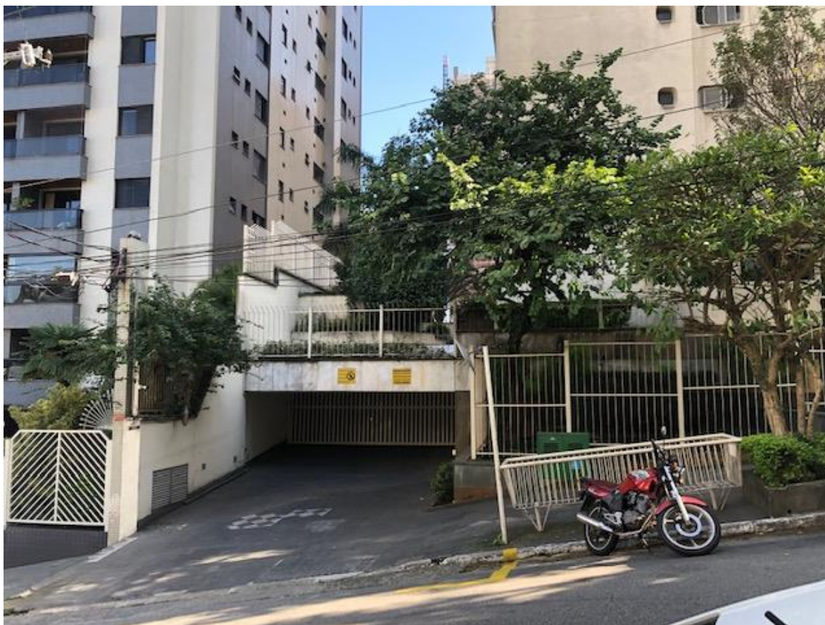
Vista do acesso à garagem (1º. Subsolo).
