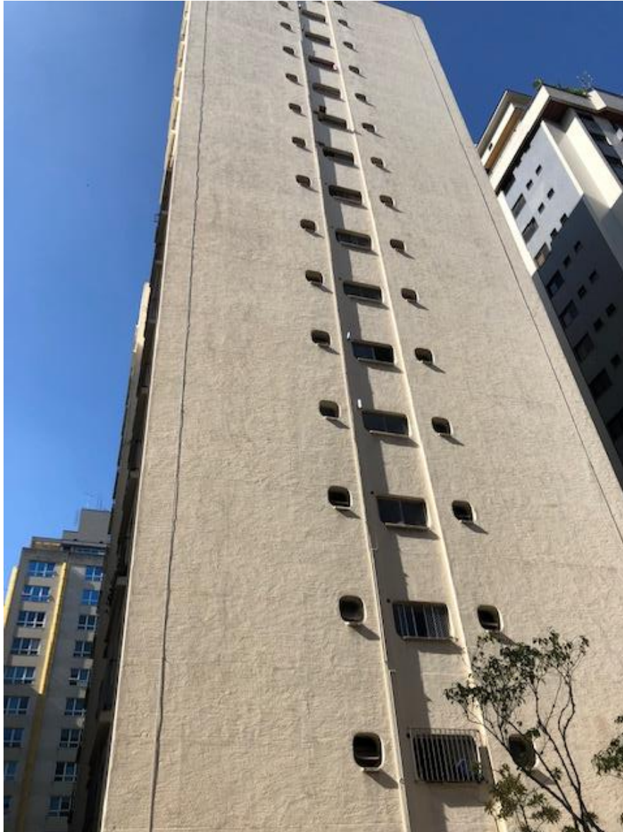
Vista da fachada dos fundos do Edifício Ilha Branca.
