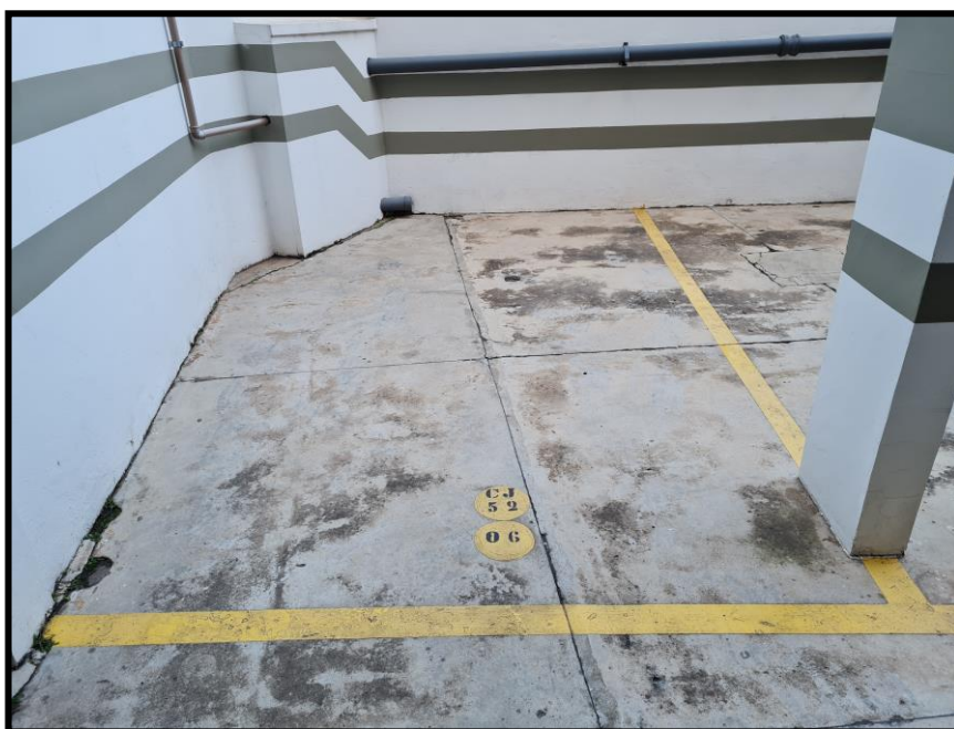
5. VISTA DO BOX DE GARAGEM DO CONJUNTO COMERCIAL Nº 52.
