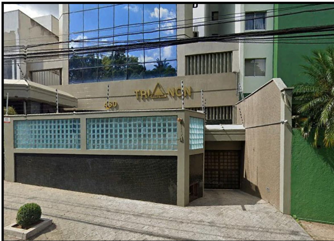
1. TOMADA DA AVENIDA BRASIL, MOSTRANDO A FACHADO DO EDIFÍCIO TRIANON.
