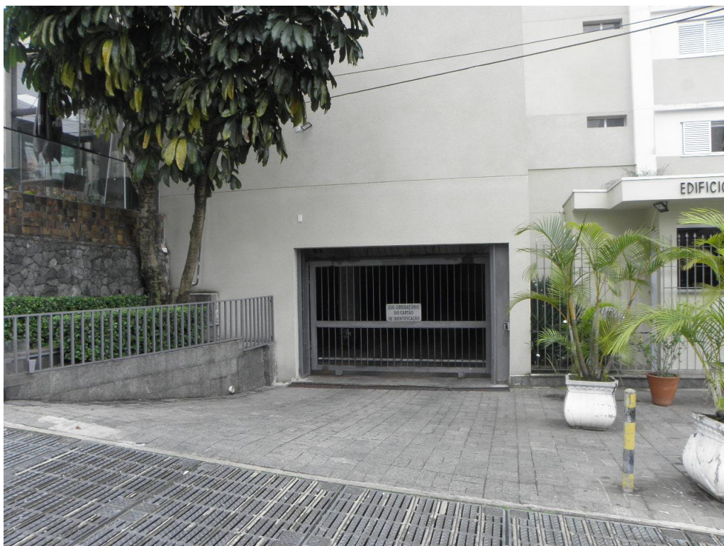
Foto: acesso da garagem.
