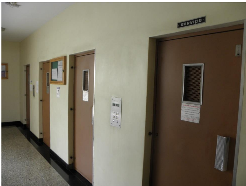
Foto: Hall de elevadores, sendo 03 elevadores sociais e 01 elevador de serviço.
