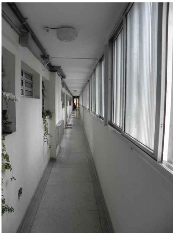
Foto: Corredor do 1º andar, de acesso do hall de elevadores ao apartamento avaliando.
