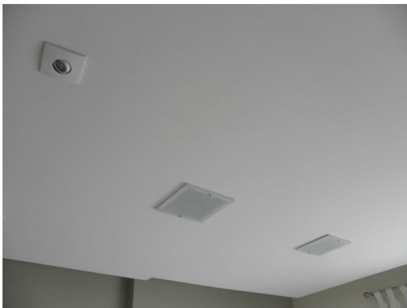
Foto: teto em gesso da sala, e sem sinais de infiltração.
