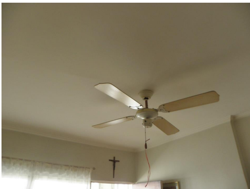
Foto: teto da sala em laje, e sem sinais de infiltração.
