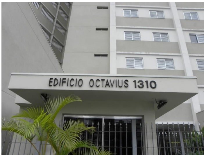
Foto: Portaria com identificação.
