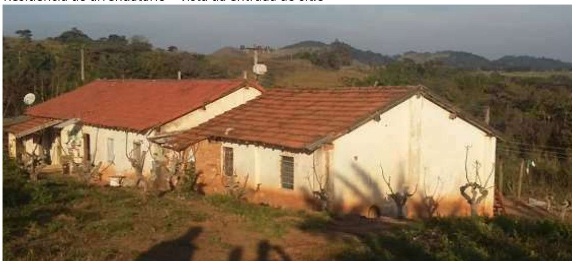
Casa dos trabalhadores
