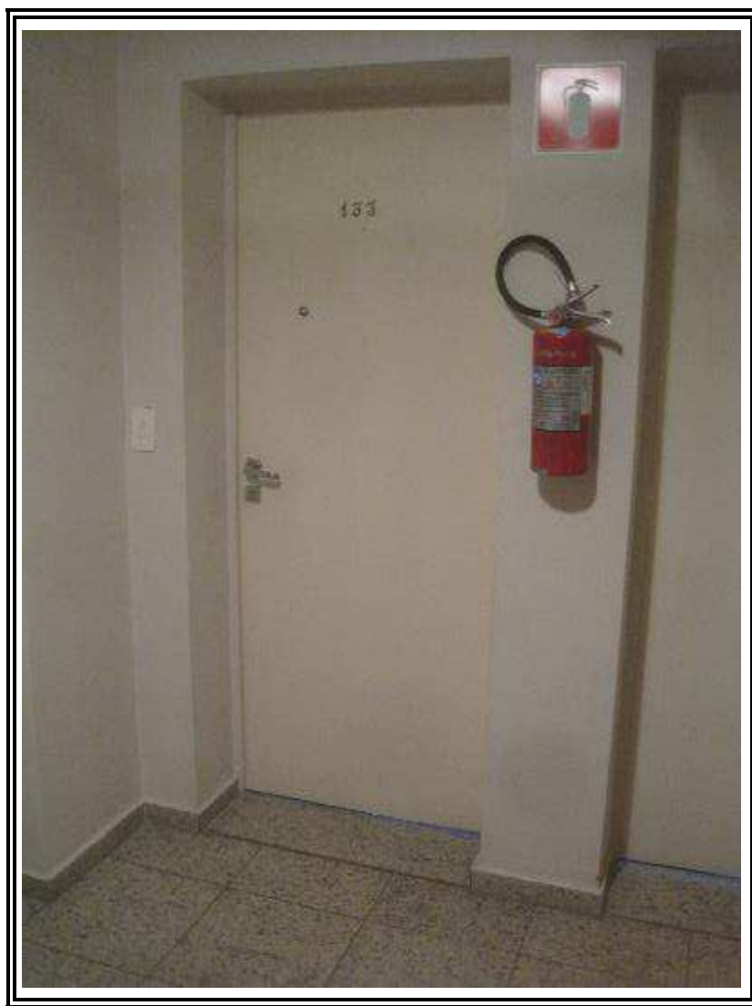
Foto nº 06: Vista geral do hall de entrada do imóvel avaliando
