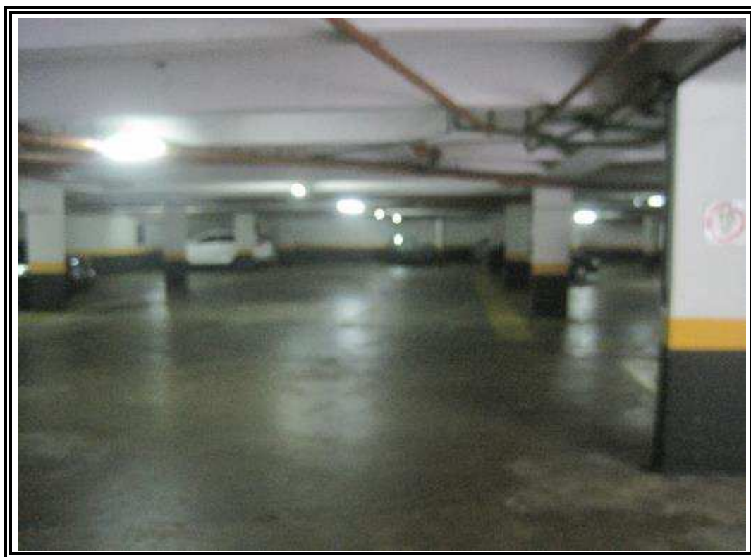
Foto nº 14: Aspecto geral do 1º subsolo
