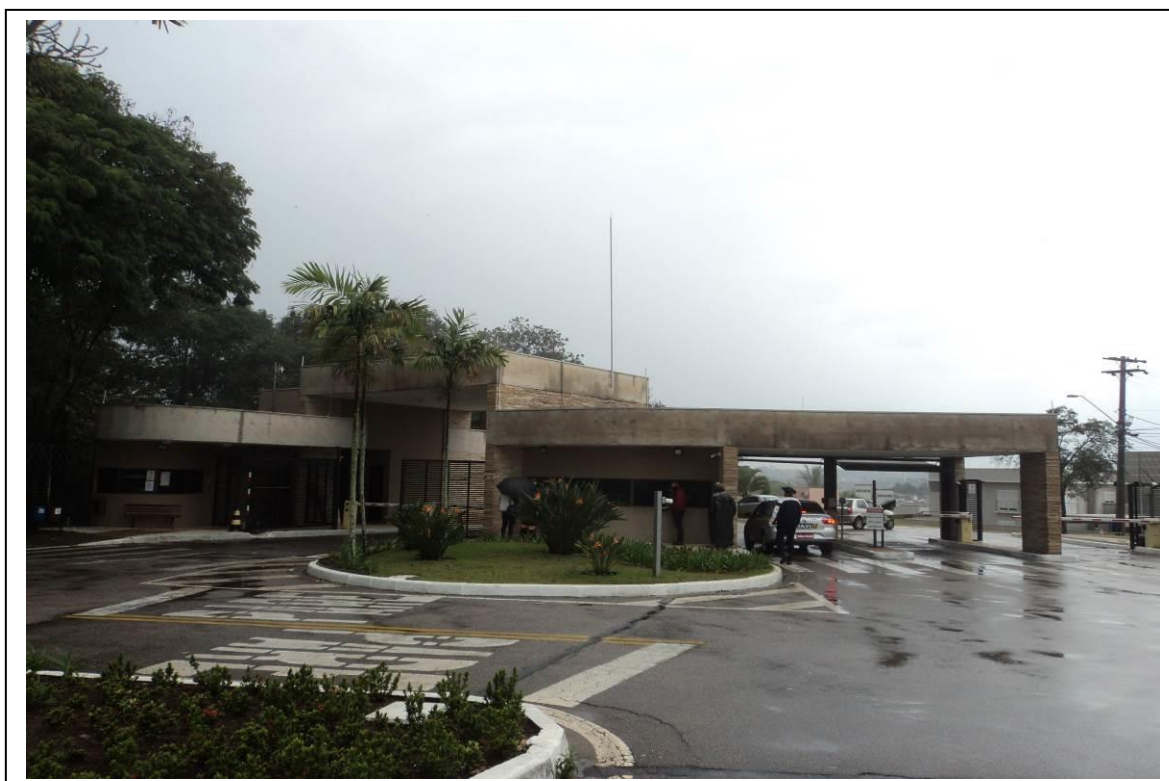
Foto 02: Vista do acesso para o Condomínio Portal do Paraíso II.
