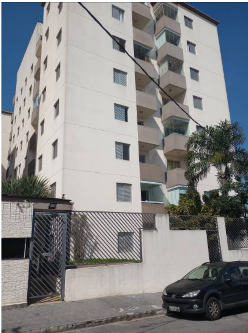
FOTO 6: FACHADA DO EDIFÍCIO.
