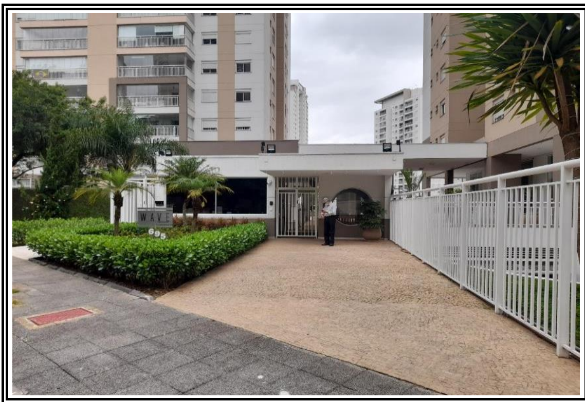
Foto nº 04: Vista da entrada do Condomínio Wave
