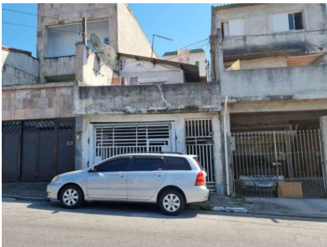
FOTO 03: Vista do imóvel em estudo sob nº 128 da Rua Saquarema.
