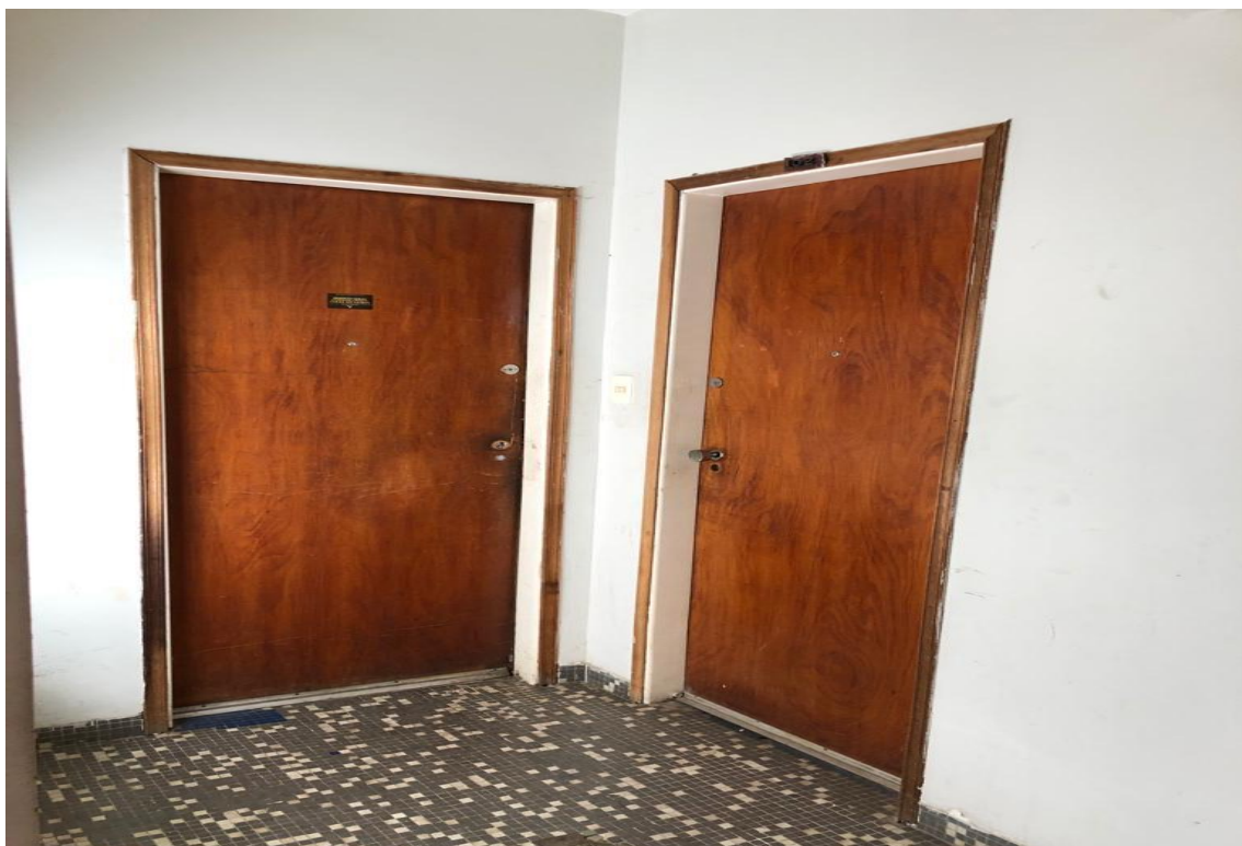
Portas de acesso ao apartamento 102
