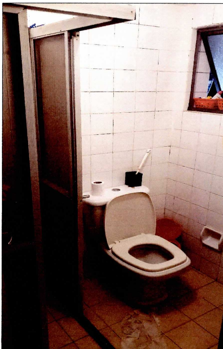
Foto 05 – Vista do banheiro.
