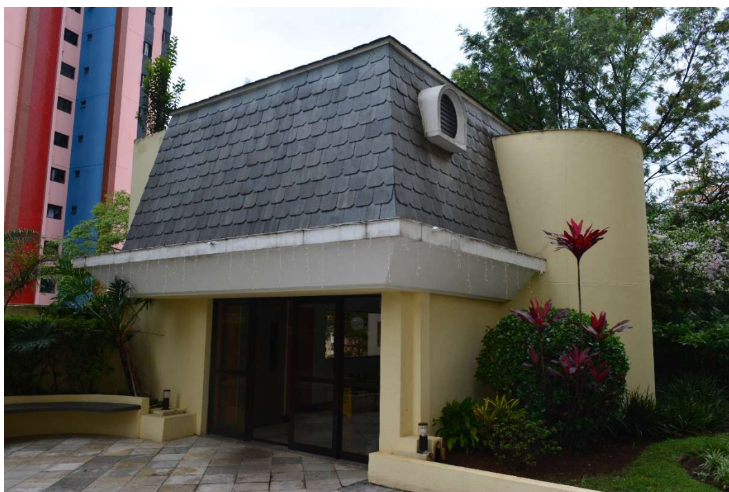
SAÍDA DO ELEVADOR DA PORTARIA PARA O TÉRREO ELEVADO.
