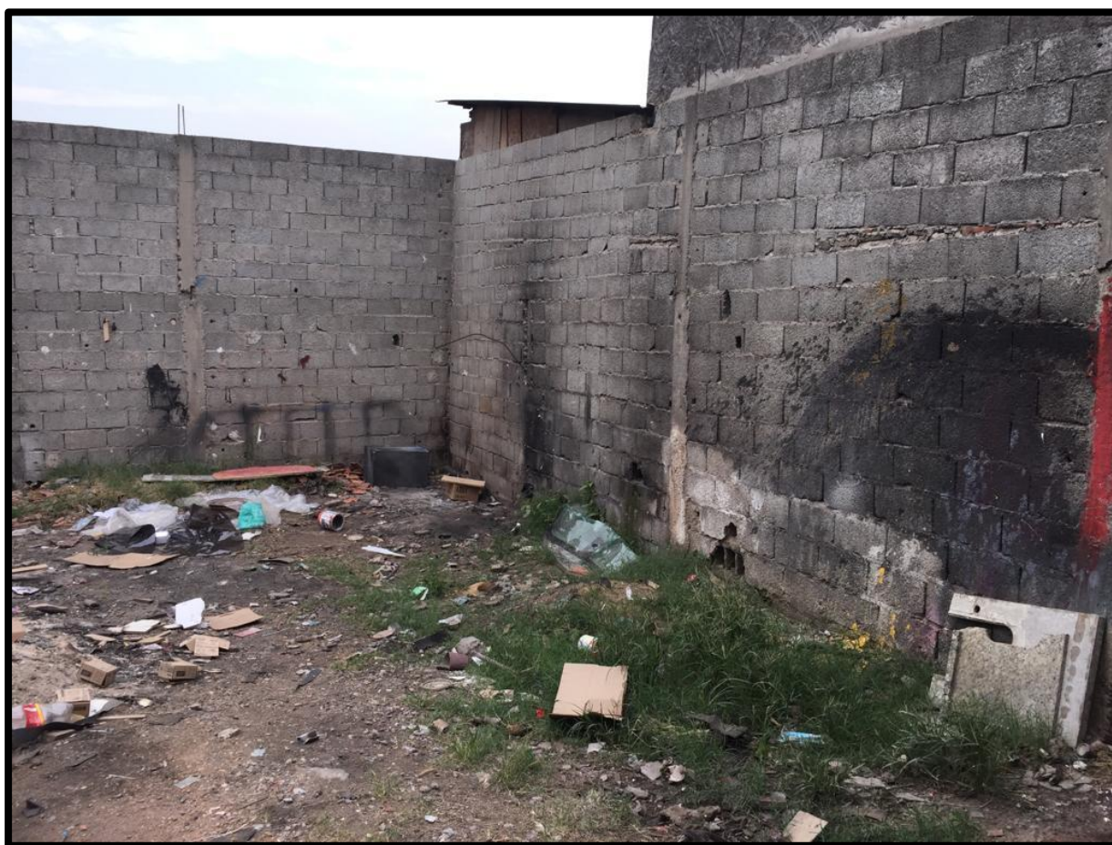
Foto nº 16 – Vista da intersecção dos muros de fechamentos de fundos e pelo lado direito, de quem da avenida olha para o imóvel.
