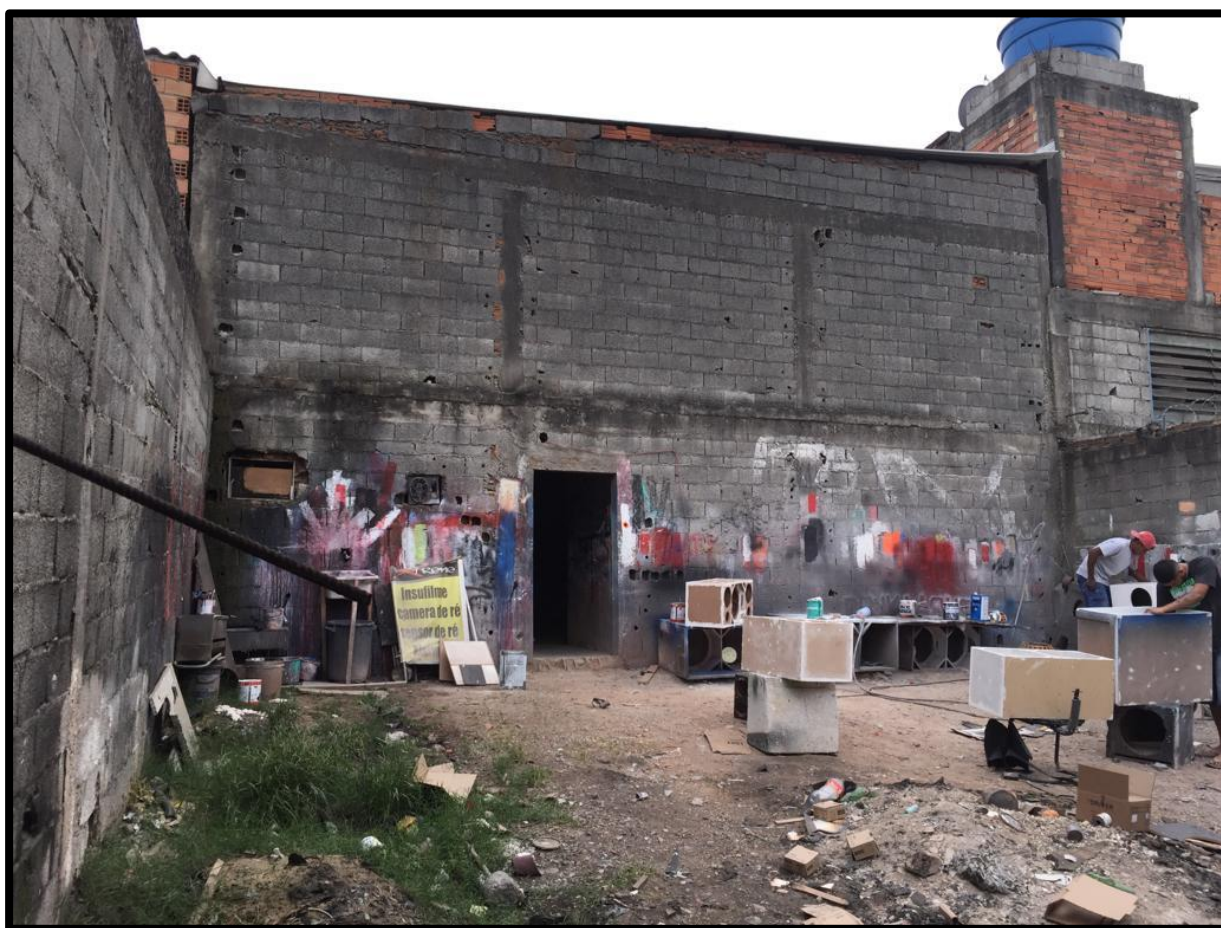
Foto nº 17 – Vista da parede de fechamento de fundos da edificação existente no terreno.
