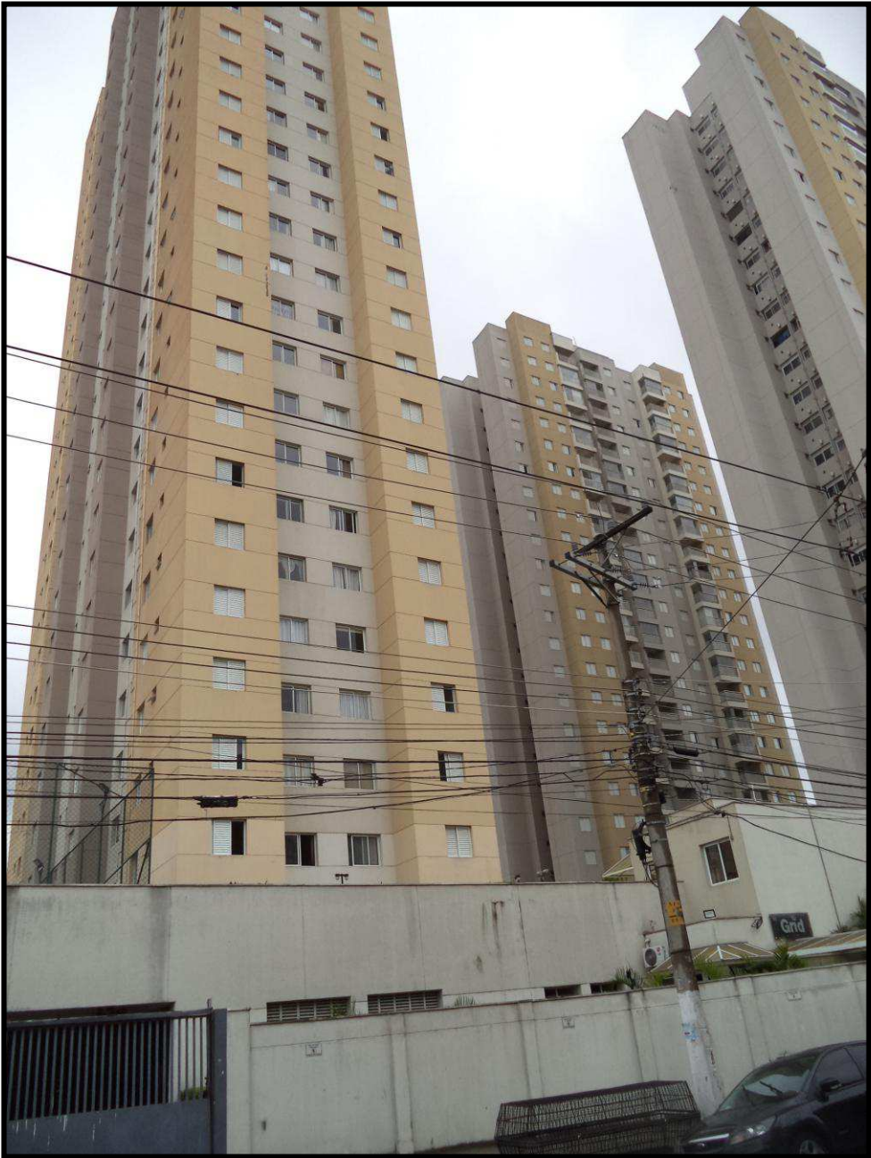
FOTO 01: Eis o Residencial Grid que abriga a unidade avalianda.
