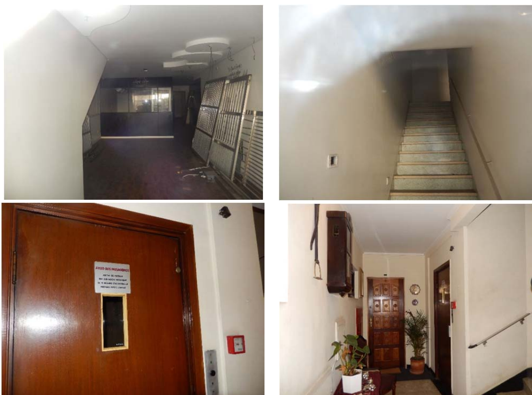
Foto nº 7 - Aspecto geral do térreo do edifício – salão, escada, elevador e hall.
