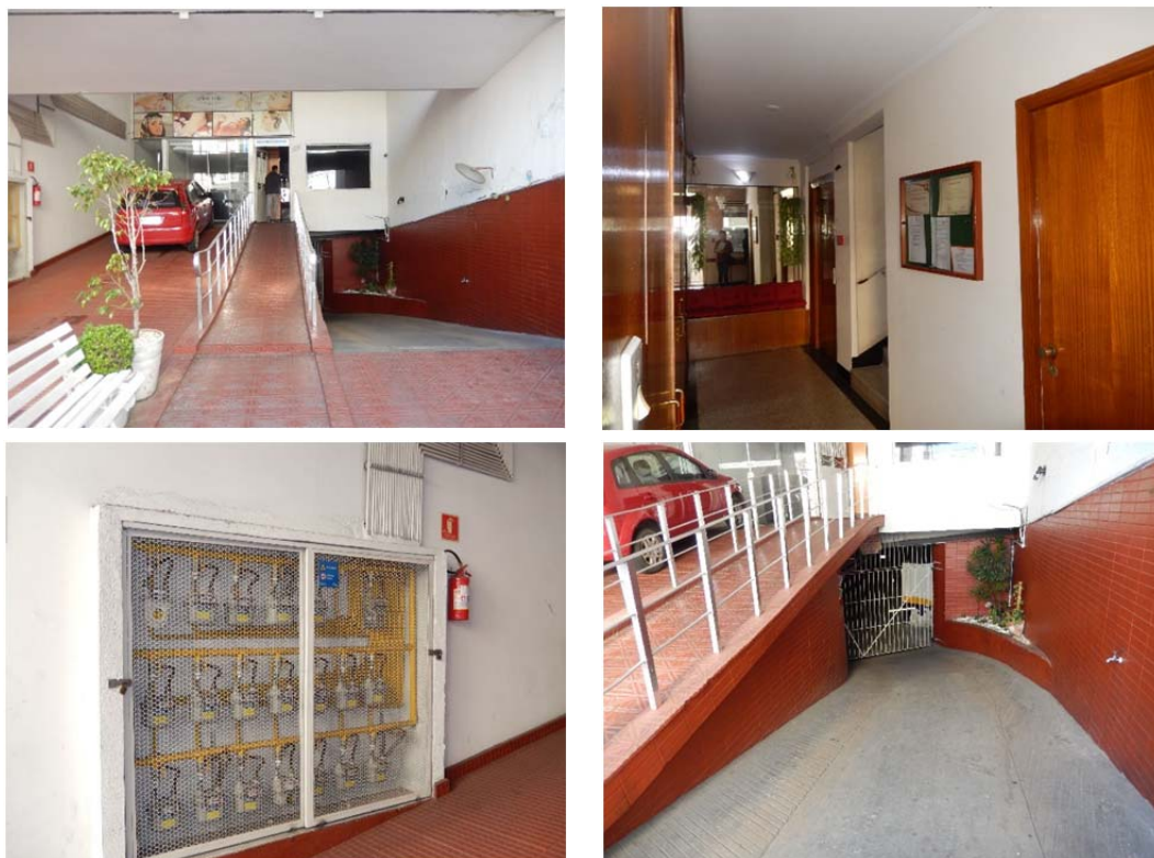
Foto nº 5 - Aspecto geral do térreo do edifício – entrada principal, hall social, quadro de medidores e rampa de acesso à garagem.
