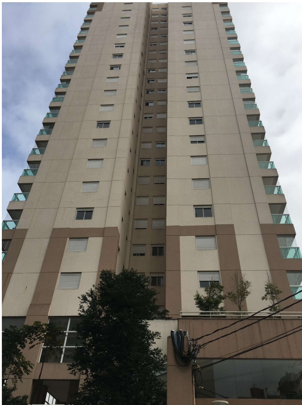
Aspectos gerais – fachada frontal edifício
