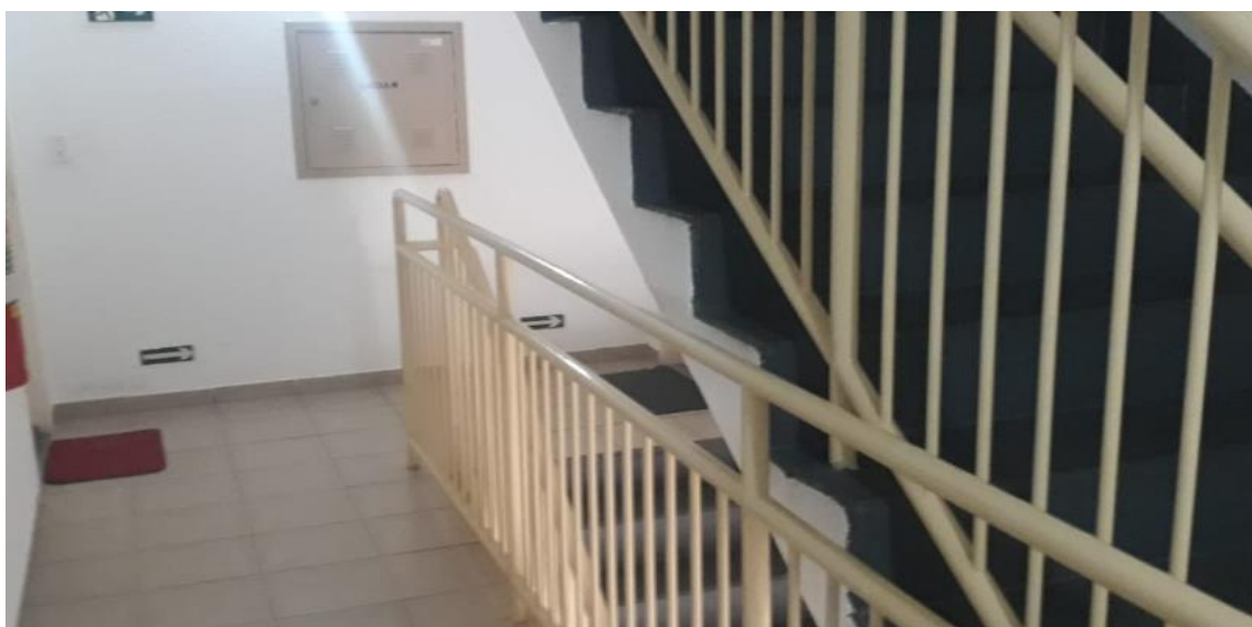
Escada de acesso
