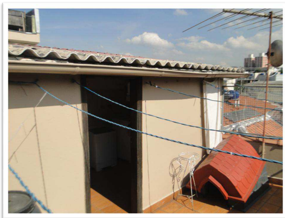
Foto nº 34 - Vista da lavanderia na laje do pavimento superior.
