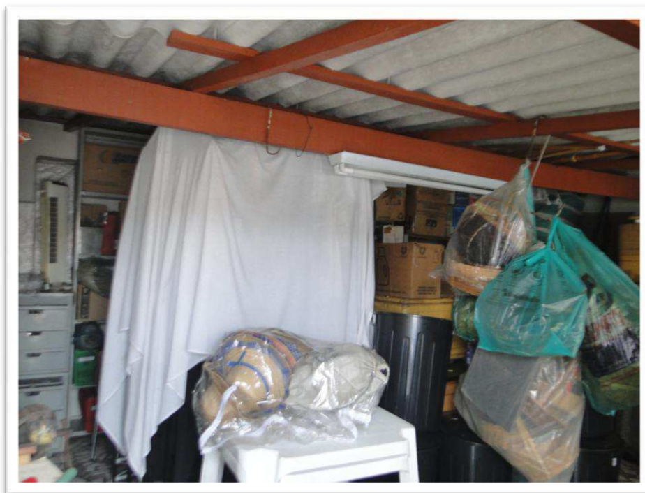
Foto nº 32 - Vista parcial do depósito, podendo-se observar que a cobertura é de telhas vãs de fibrocimento.
