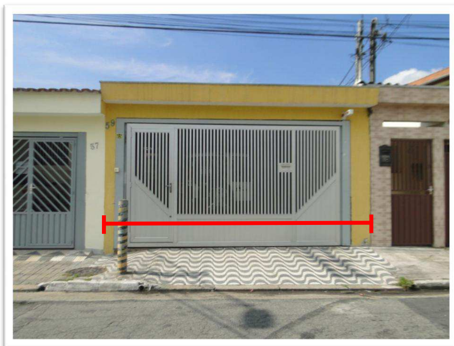
Foto nº 1 - Vista da testada do imóvel para a Rua Gaspar Barreto, nº 59, tal como indicação da linha vermelha.
