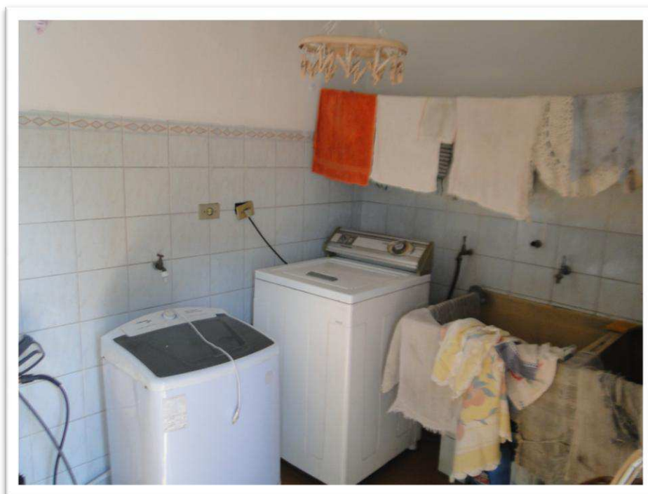
Foto nº 35 - Vista parcial da lavanderia, também com telhas vãs de fibro-cimento e piso cerâmico.
