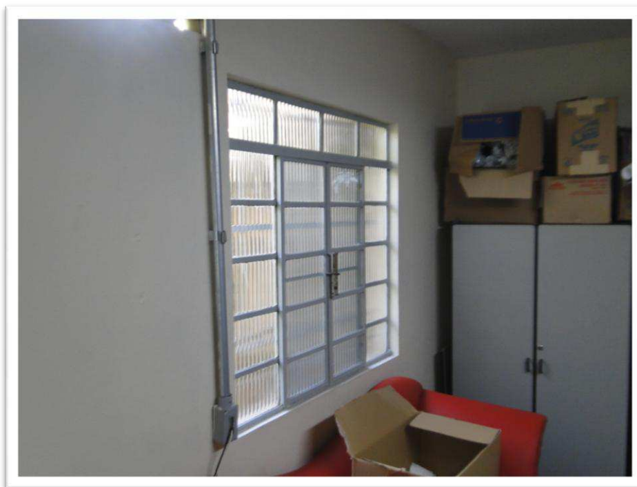
Foto nº 28 - Detalhe da esquadria desse escritório na parte dos fundos do terreno que é de ferro do tipo de “correr” com vidro canelado.
