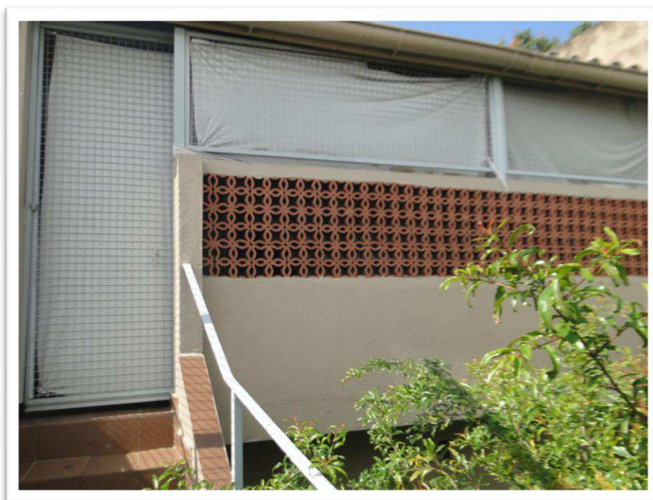
Foto nº 31 - Vista da entrada desse depósito.
