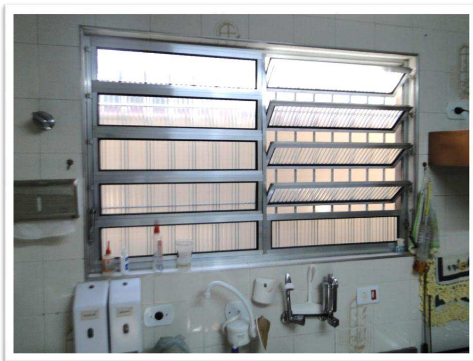
Foto nº 16 - Detalhe da esquadria da cozinha, que é de alumínio do tipo basculante com vidro canelado.
