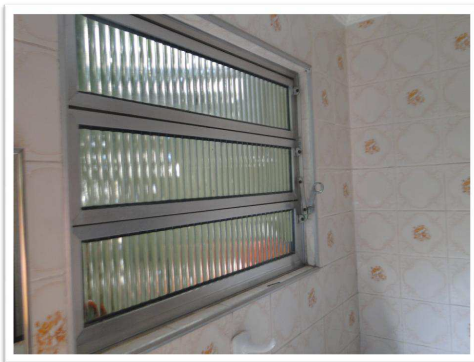
Foto nº 24 - Detalhe da esquadria do WC retro mencionado que é de alumínio do tipo basculante com vidro canelado.
