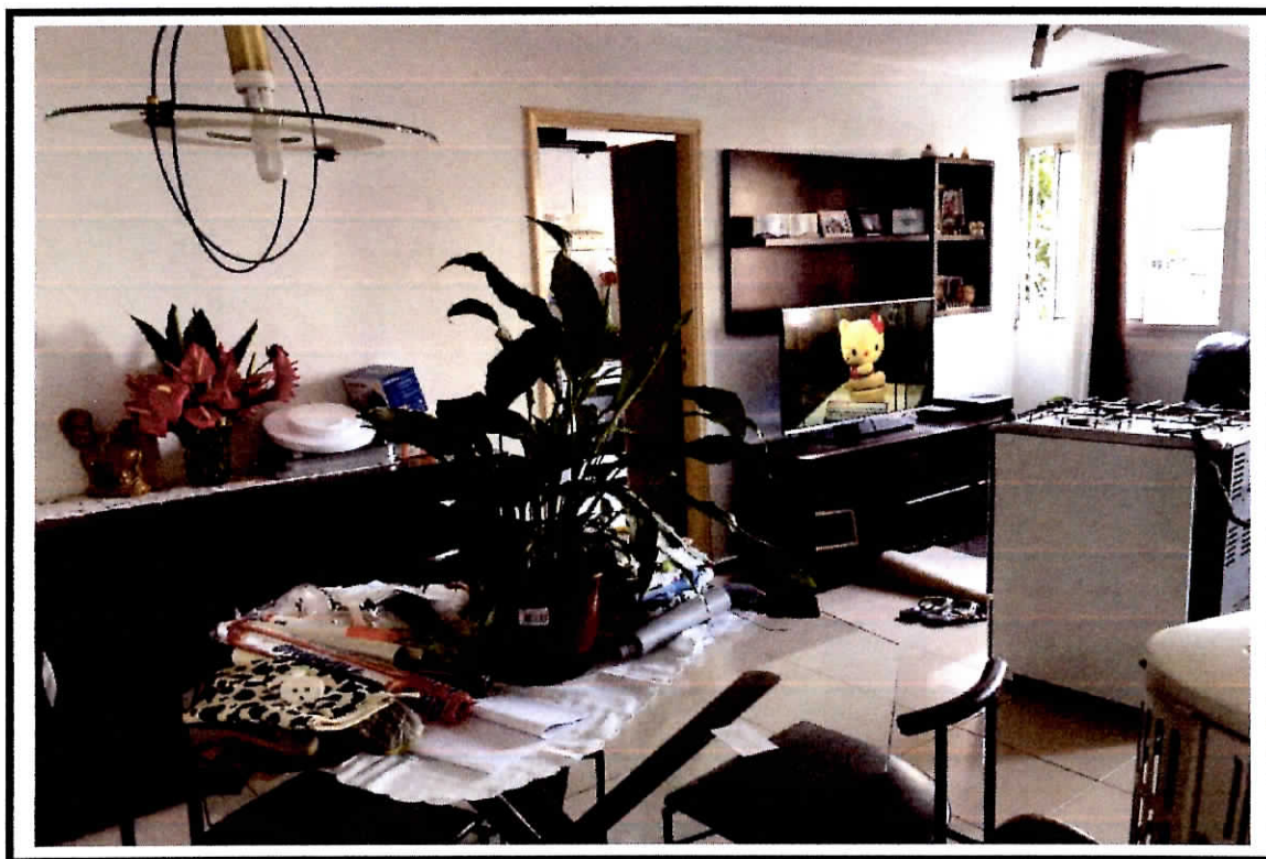
Foto nº 05: Vista da sala. Suas principais características construtivas são: piso cerâmico, paredes revestidas em massa corrida pintadas em látex, forro em laje e esquadrias de alumínio.
