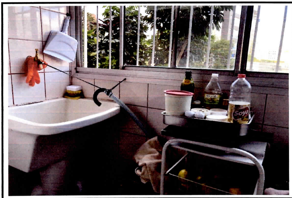
Foto nº 08: Vista da área de serviço. Suas principais características construtivas são: piso cerâmico, paredes azulejadas até o teto, forro em laje e esquadrias de alumínio.
