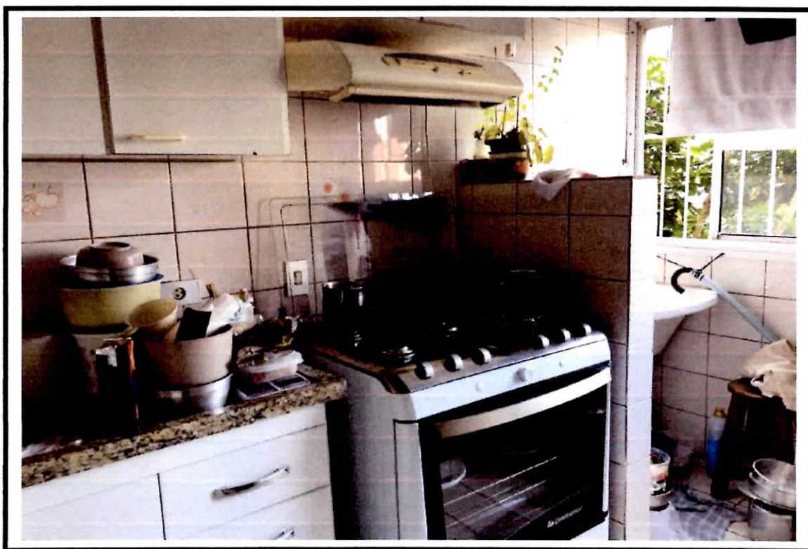
Foto nº 07: Vista da cozinha. Suas principais características construtivas são: piso cerâmico, paredes azulejadas até o teto.
