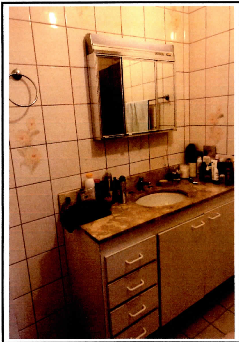
Foto nº 06: Vista do banheiro. Suas principais características construtivas são: piso cerâmico, paredes azulejadas até o teto, forro em laje.
