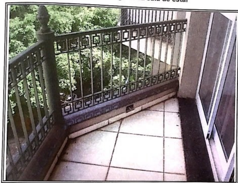
Foto nº 08: Vista da sacada da sala de estar
