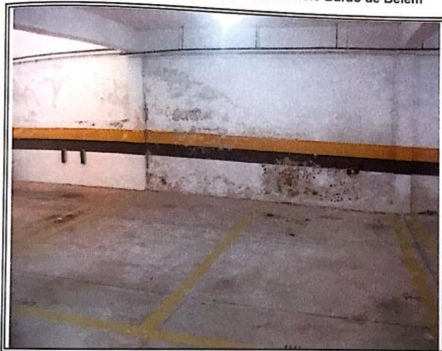
Foto nº 24: Vista das vagas de garagem da unidade autônoma em avaliação
