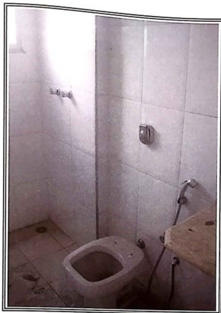
Foto nº 18: Vista do banheiro da suíte 03
