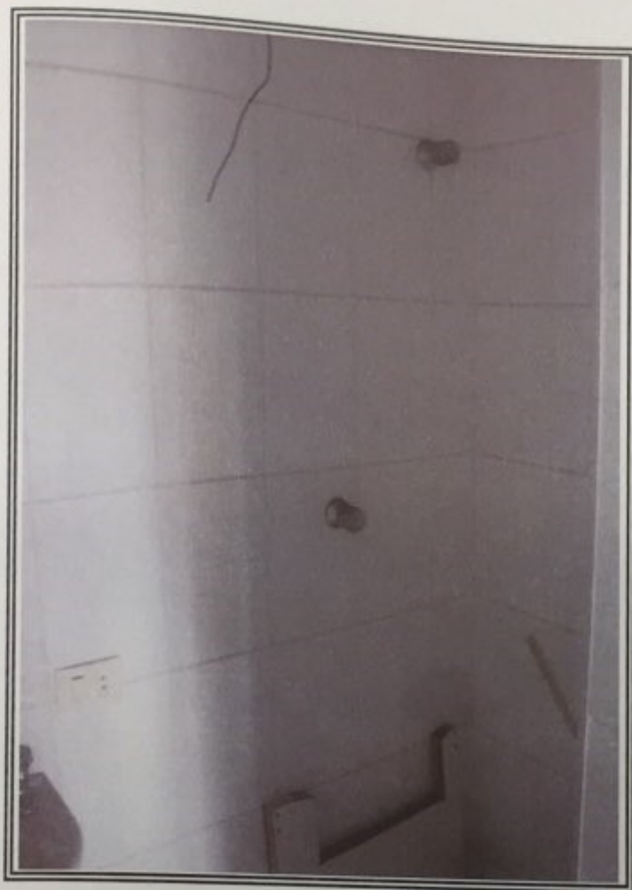
Foto nº 22: Vista do banheiro de empregada
