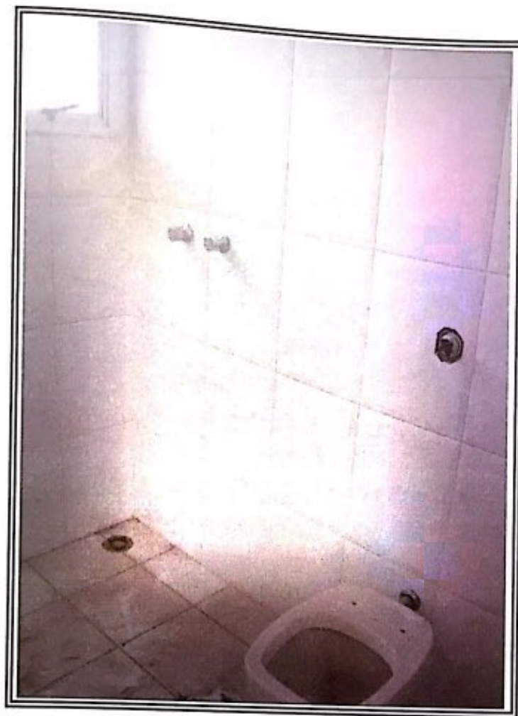
Foto nº 15: Vista do banheiro da suíte 02
