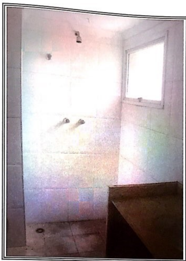
Foto nº 12: Vista do banheiro da suíte 01
