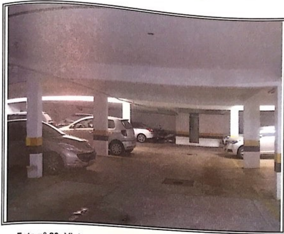
Foto nº 23: Vista geral da garagem do Edifício Barão de Belém
