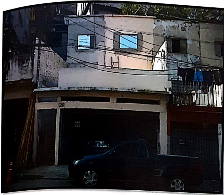
Foto 1. Vista Imóvel Avaliando.
