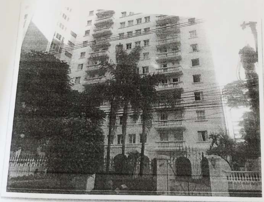
Foto nº 1 - Vista da testada do prédio para a via em questão.
