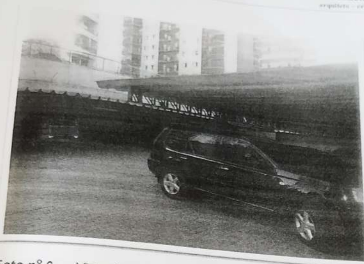
Foto nº 6 - Vista de uma parte dos fundos do prédio destinada a guarda de veículos.
