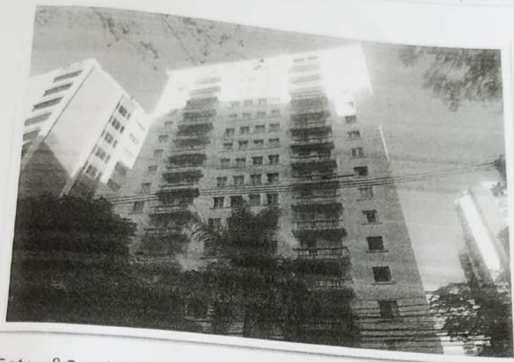
Foto nº 2 - Vista da fachada do Edifício "Mansão La Fontaine".
