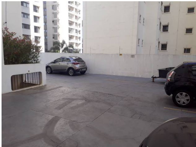
Foto 19: Vista geral da garagem do térreo
