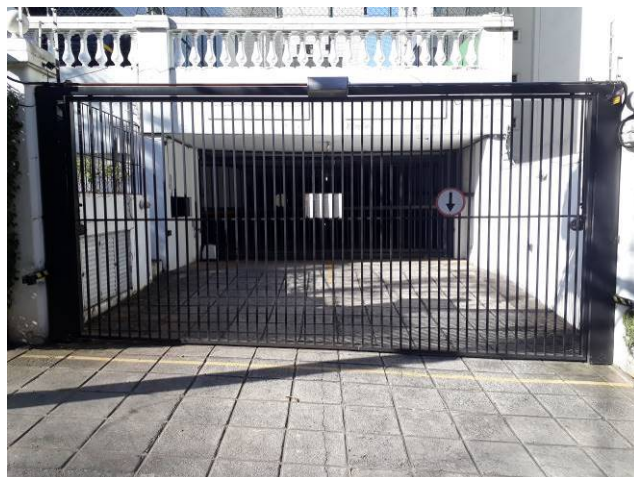
Foto 10: Entrada e saída de veículos das garagens dos subsolos, feita pela Rua Harmonia
