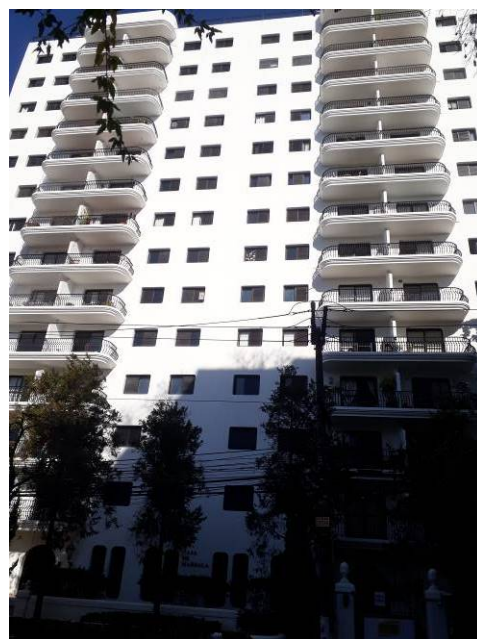
Fotos 3 e 4: Fachada principal do condomínio voltada para a Rua Rodésia
