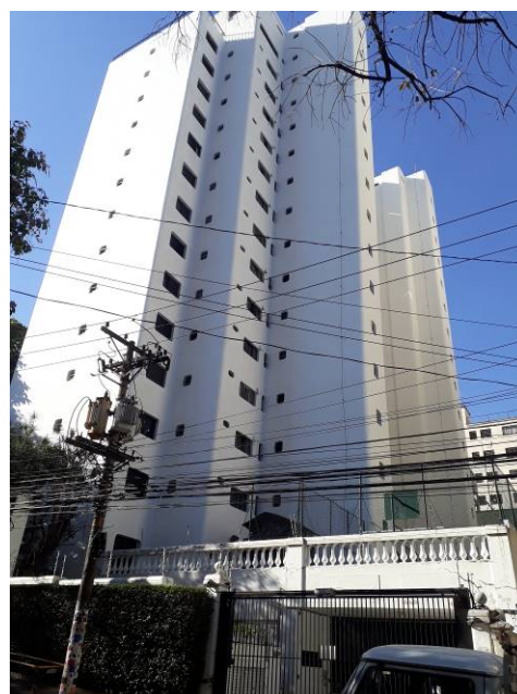
Fotos 7 e 8: Vista da fachada lateral do condomínio voltada para a Rua Harmonia
