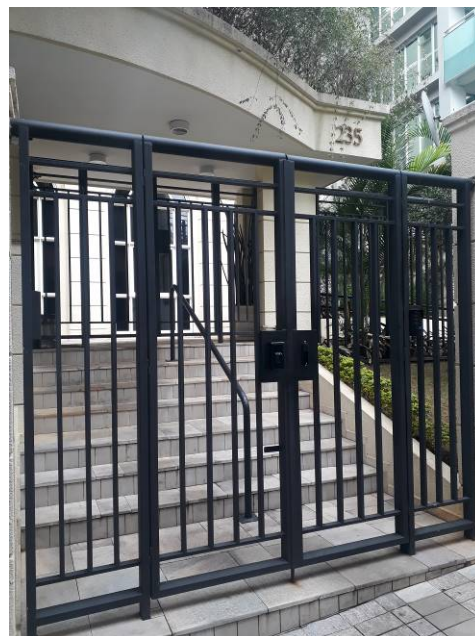
Fotos 55 e 56: Entrada de pedestres, portaria e identificação do edifício
