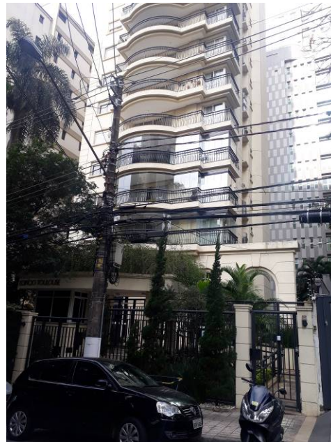
Fotos 53 e 54: Outras vistas da fachada do condomínio
