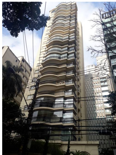
Fotos 51 e 52: Fachada do condomínio
