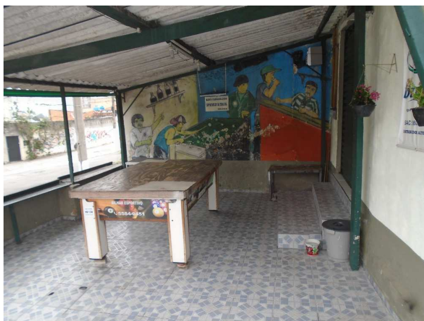
Parte frontal, edificação 02
