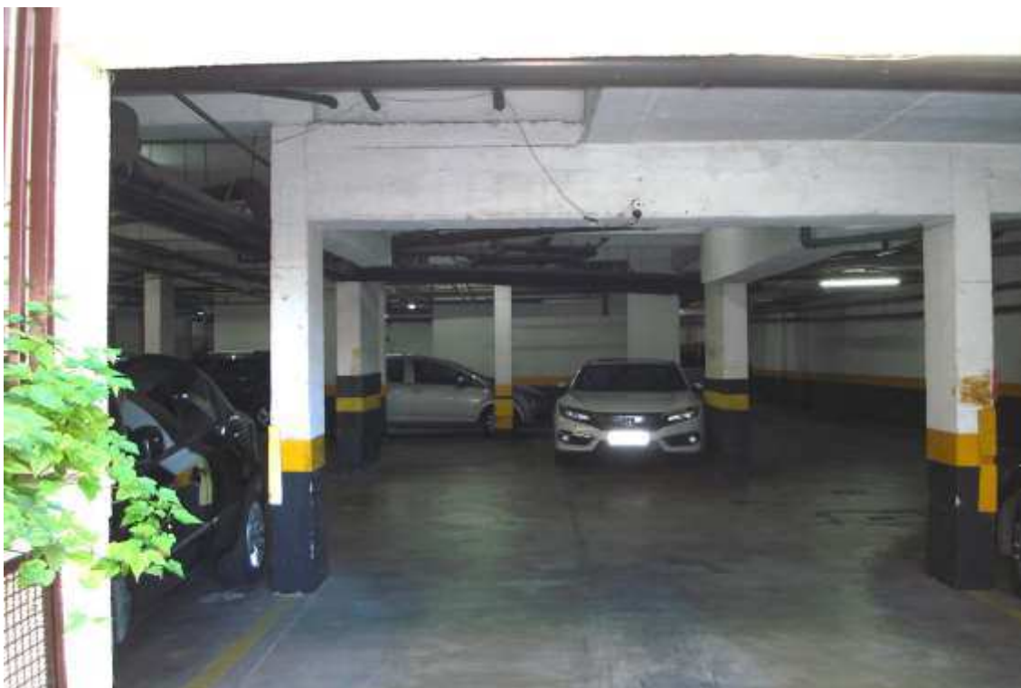
FOTO Nº 17 – Vista da garagem no edifício Piazza Isabella.
