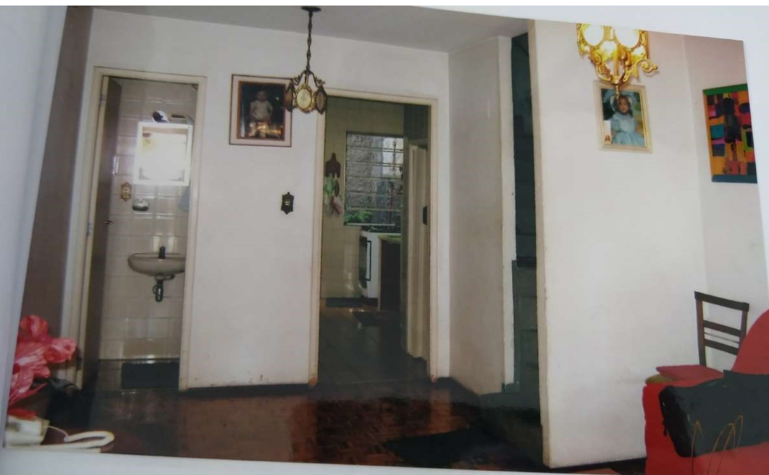
Foto nº 5- interior da sala no térreo com piso de cerâmica e paredes com massa corrida e látex.
