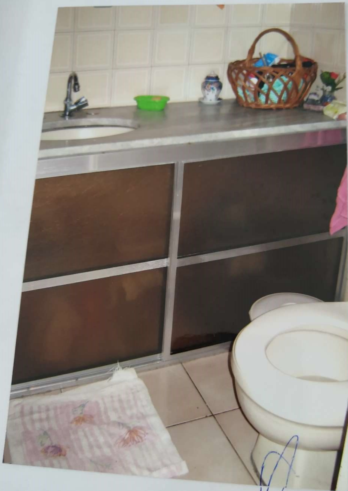
ial com piso cerâmico, paredes com azulejos, lavatório com bancada de mármore e gabinete de acrílico comercial.
