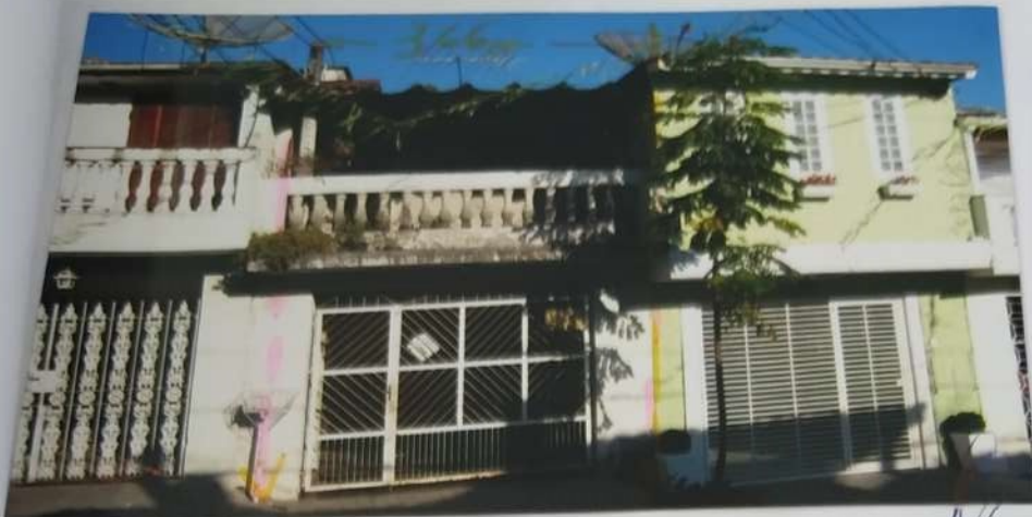
Foto n 01 – fachada do imóvel avaliando, frente para a Rua José Carlos de Rezende, com 3,66 m
