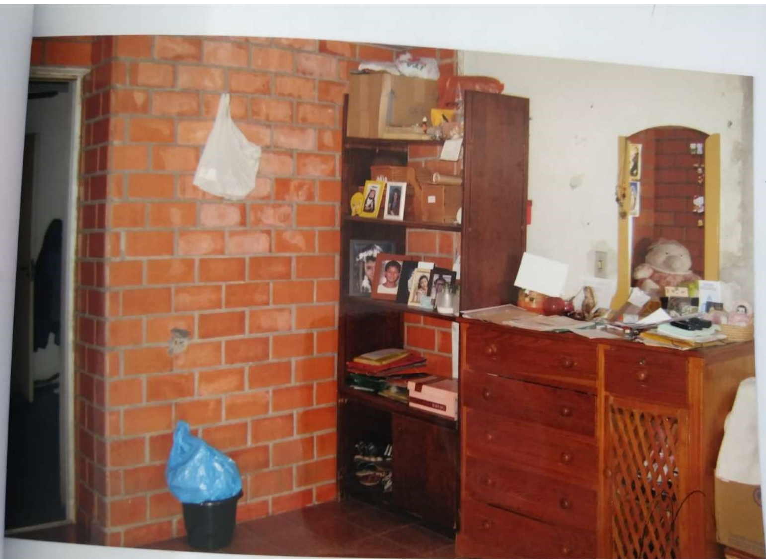
oto nº 12 – dormitório da frente com piso cerâmico e parede rebocada sem pintura e forro de PMC.
