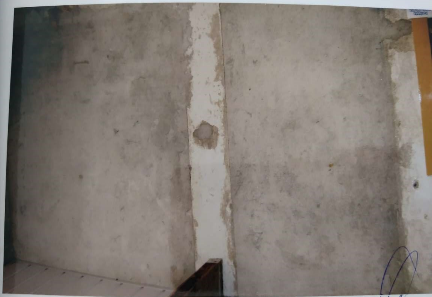
Foto nº 13 – detalhe da parede do dormitório da frente rebocado sem pintura.
