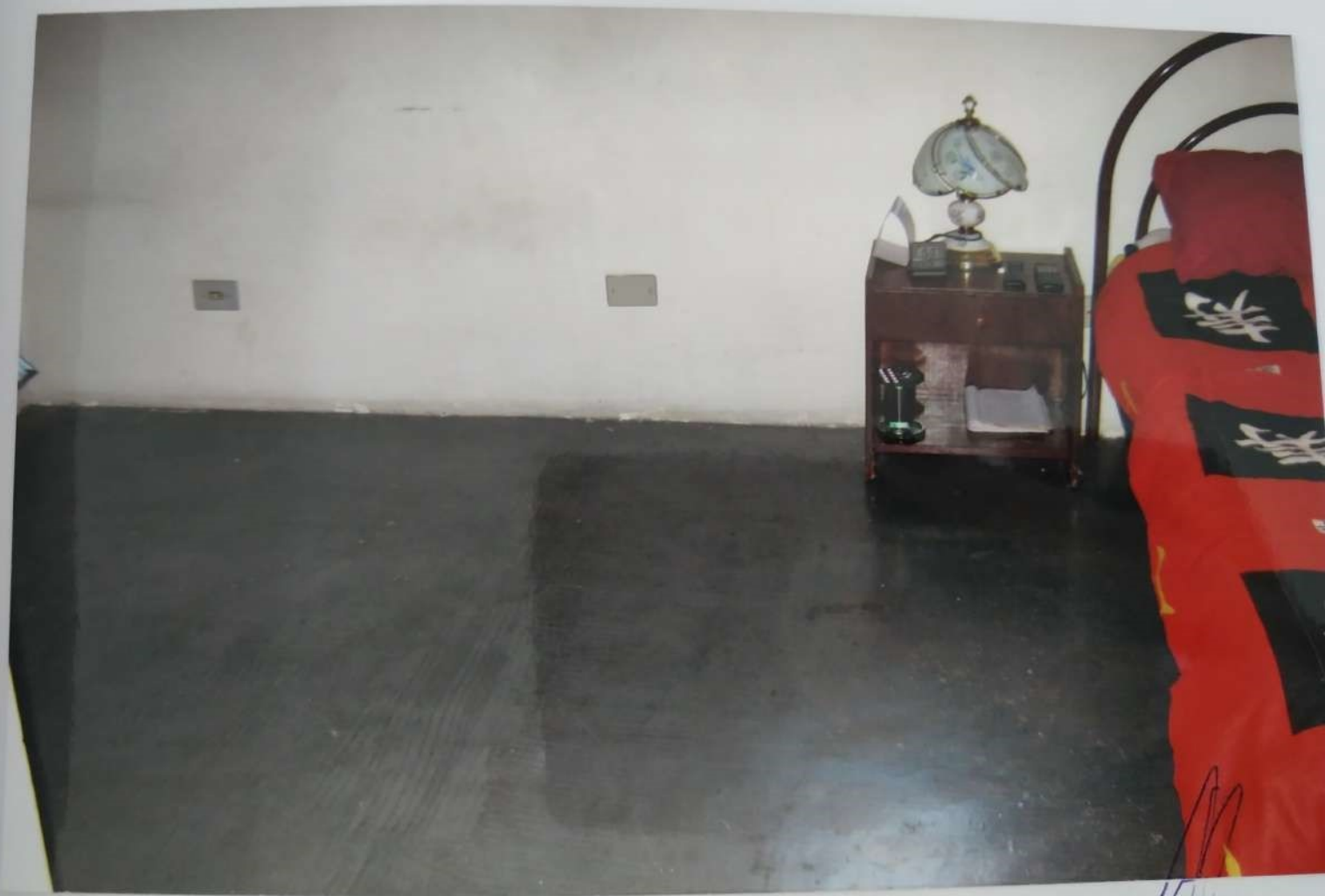
Foto nº 16 – dormitório da suíte com piso de cimento e paredes com pintura látex.
