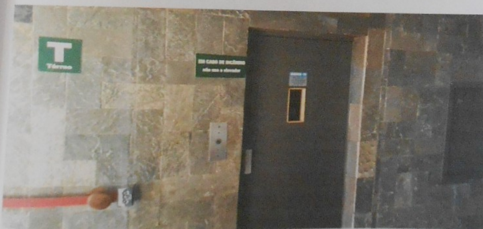
Elevador de acesso aos apartamentos
