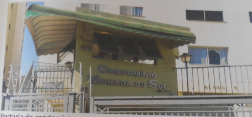
Portaria do condomínio
