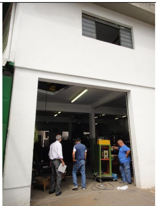
Foto 6 – outra vista da fachada interna, entrada.
