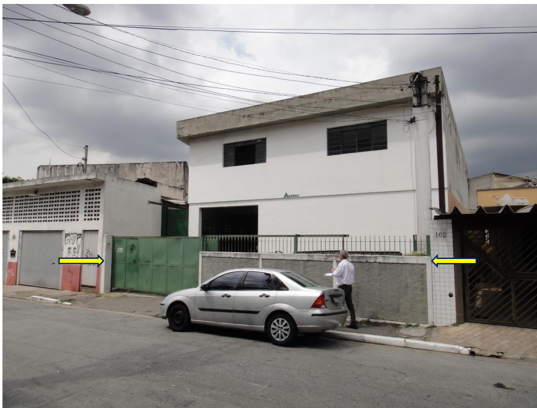
Foto 1 – fachada do imóvel avaliando.
