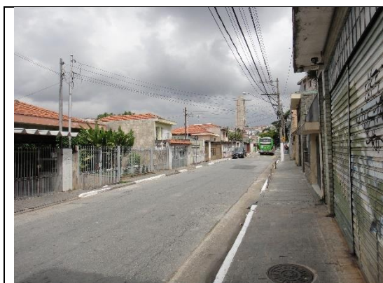
Foto 2 – vista da Rua Adele Zarzur sentido Rua Dom Manuel D'elboux.
