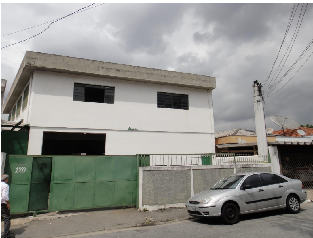
Foto 4 – fachada do imóvel avaliando.
