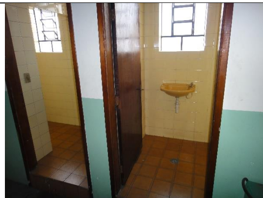
Foto 21 – vista dos sanitários.
