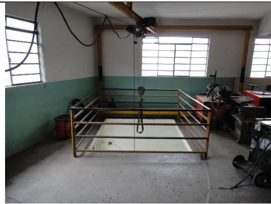
Foto 19 – detalhe para abertura na laje no pavimento superior.
