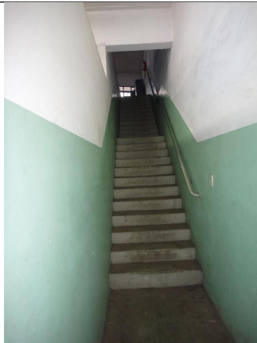
Foto 16 – escada de acesso ao pavimento superior.
