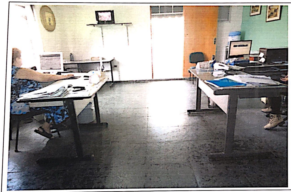
Foto 14: Vista de outro escritório. Suas principais características construtivas são: piso em ardósia, paredes revestidas em massa pintadas em látex, forro em laje e esquadrias de alumínio.
