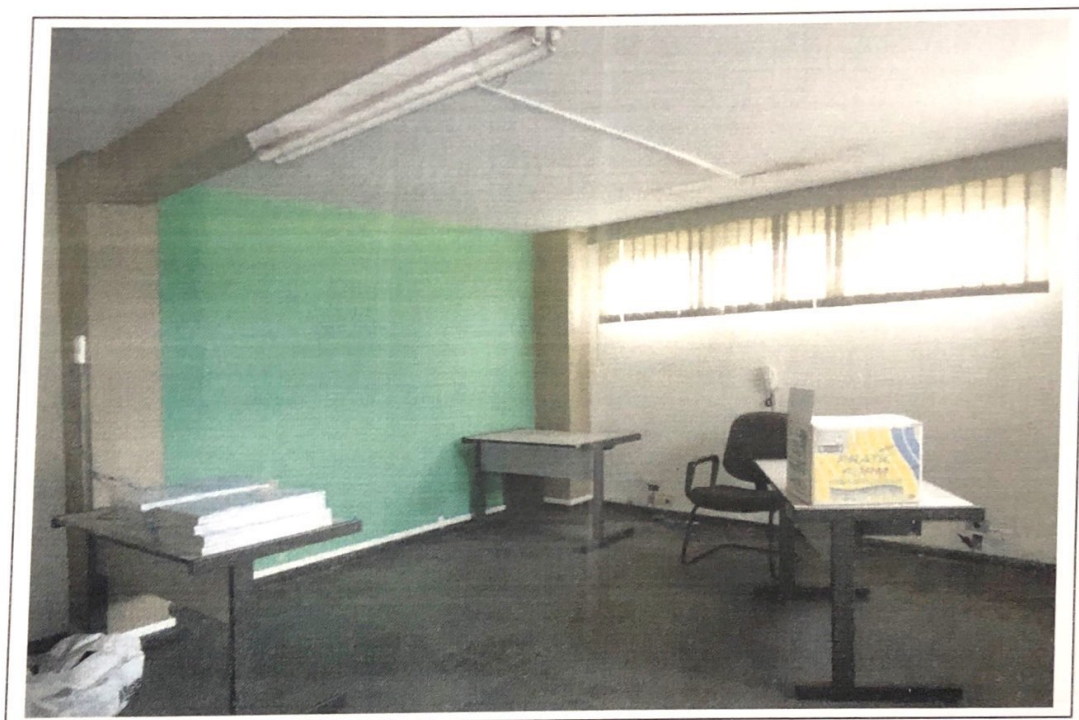
Foto 08: Vista de um escritório. Suas principais características construtivas são: piso em ardósia, paredes revestidas em massa pintadas em látex, forro em gesso e esquadrias de alumínio.
