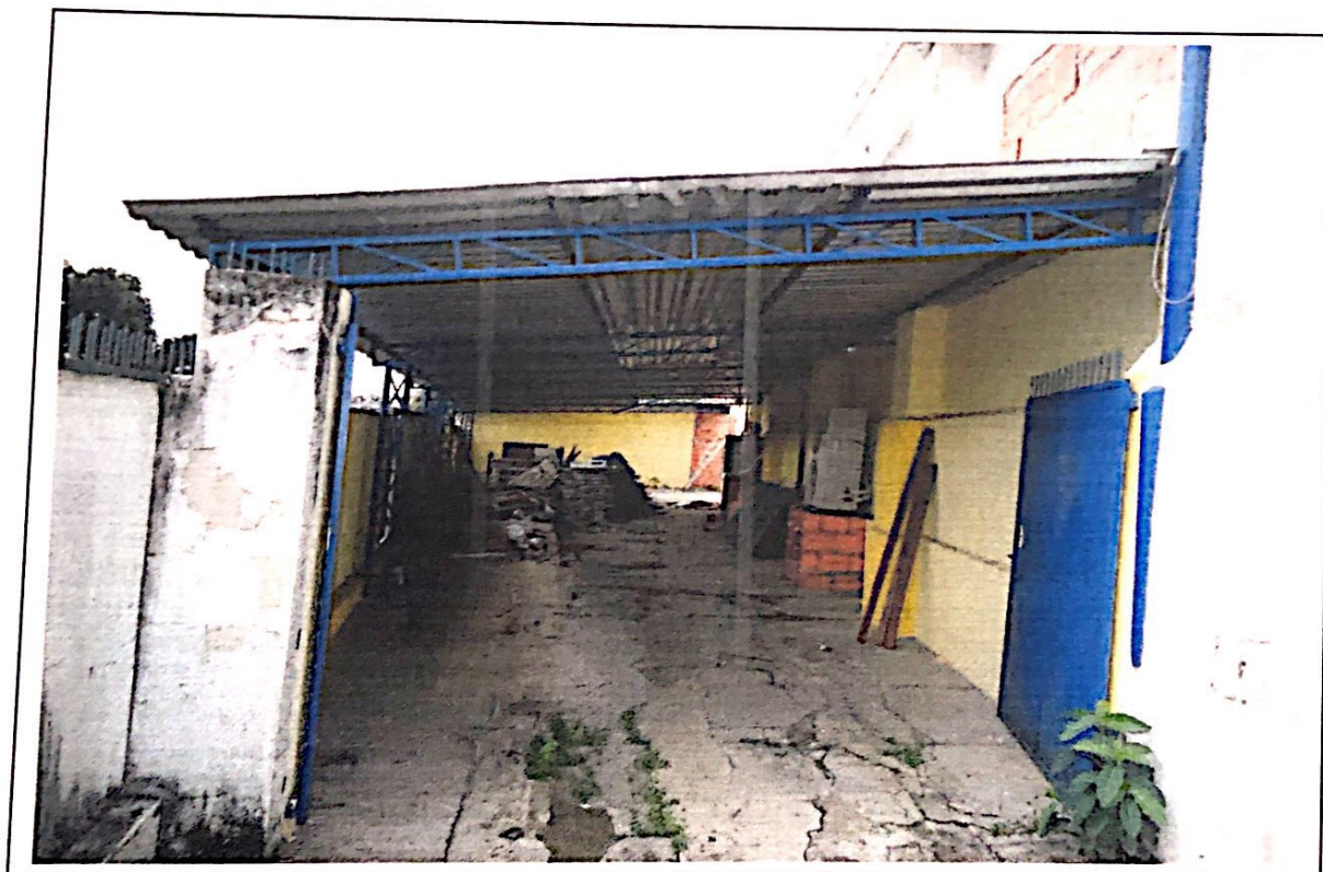
Foto 07: Vista de uma área coberta com telhas de zinco.
