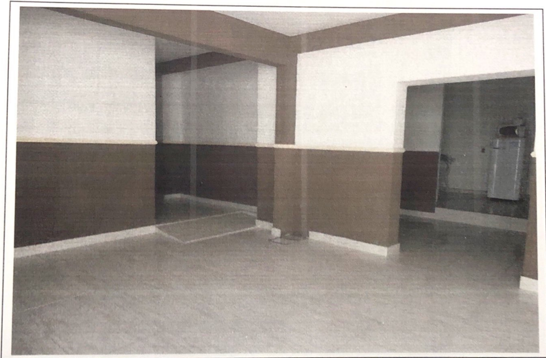
Foto 18: Vista da parte atualmente locada e em fase de reforma. Suas principais características construtivas são: piso cerâmico, paredes revestidas em massa pintadas em látex, forro rebaixado em gesso.
