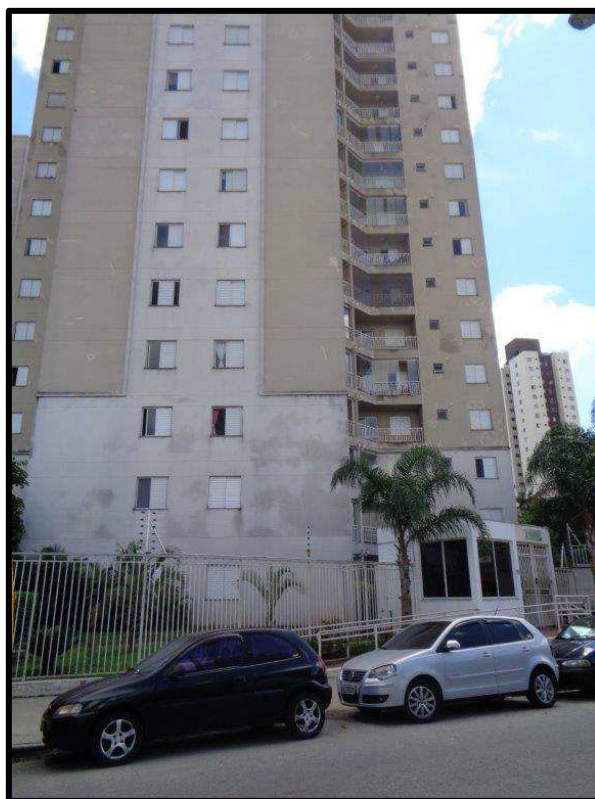
Foto 2: Fachada do prédio
