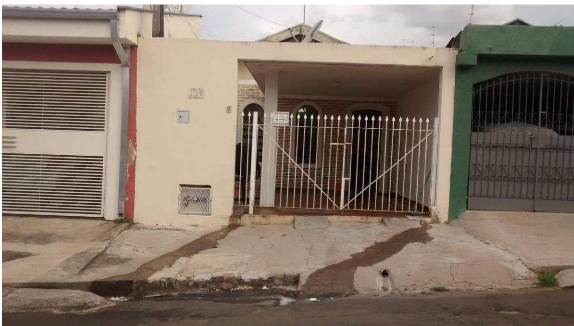
FOTO n.01 – Fachada do imóvel avaliando.
