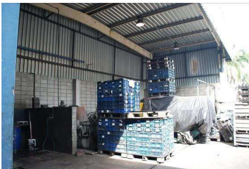
Aspectos da área externa do Galpão 4.
