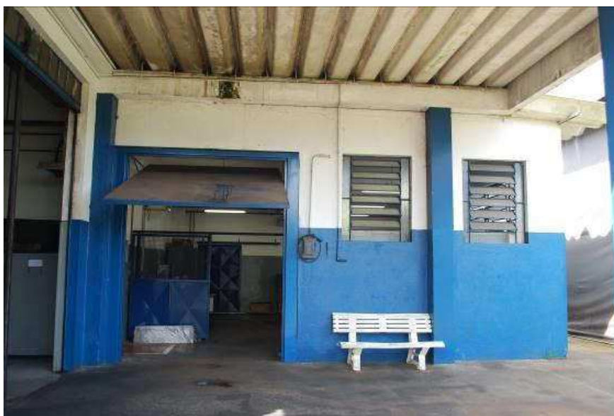
Fachada do prédio da manutenção.
