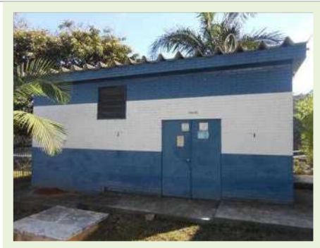
Cabine de Força 1
