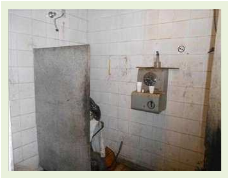
Fábrica 1 - Antigo Vestiário
