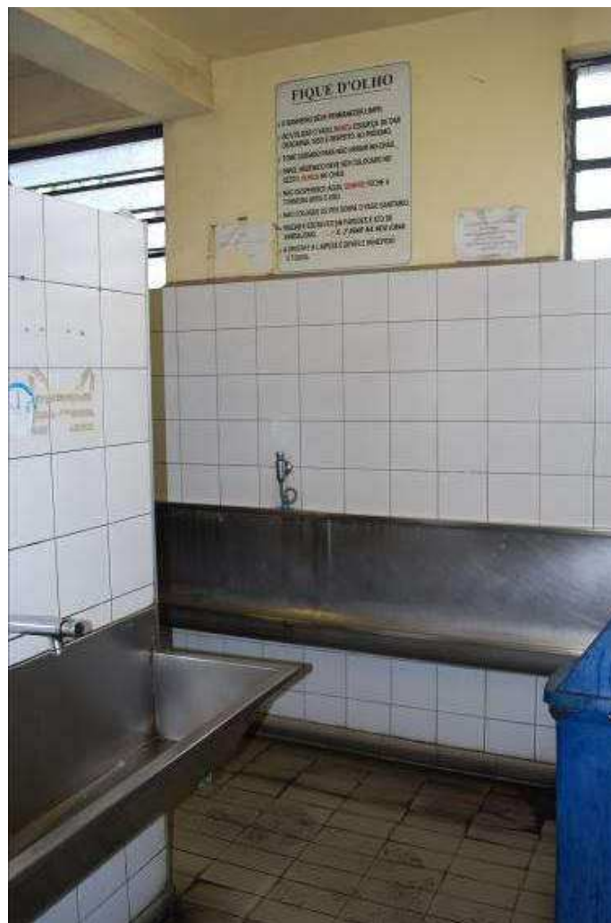
Detalhes de acabamento e conservação do banheiro.
