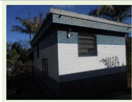
Cabine de Força 1
