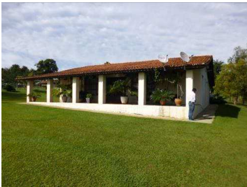
Fachada da casa principal.
