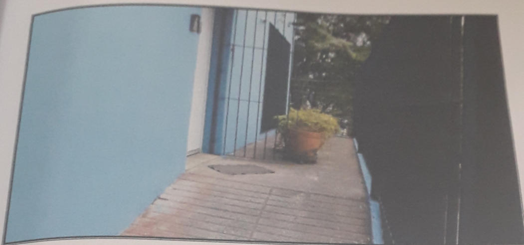
Foto 10 – Detalhe do acesso lateral ao imóvel.
