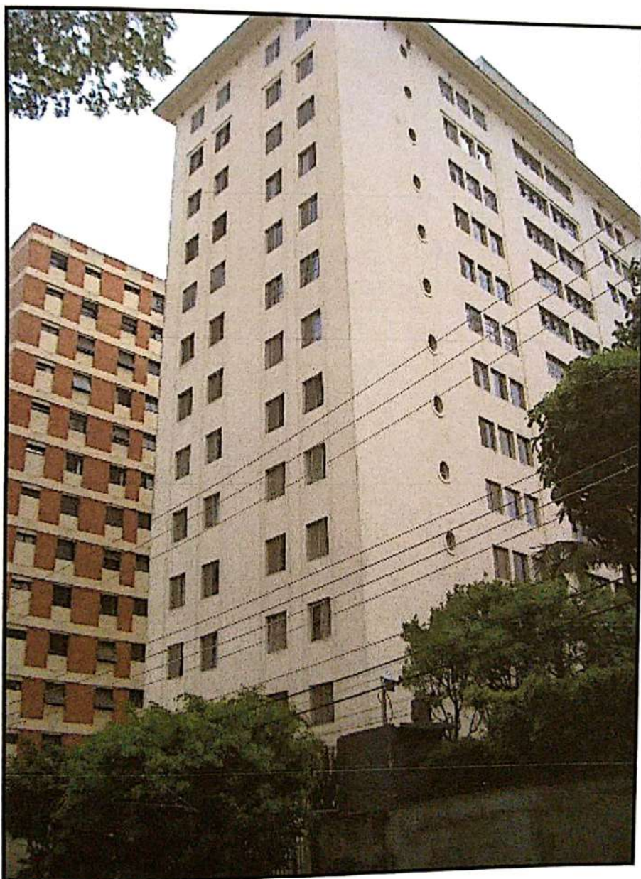
FOTO 01 : Eis o Edifício Arlete que abriga a unidade avalianda.
