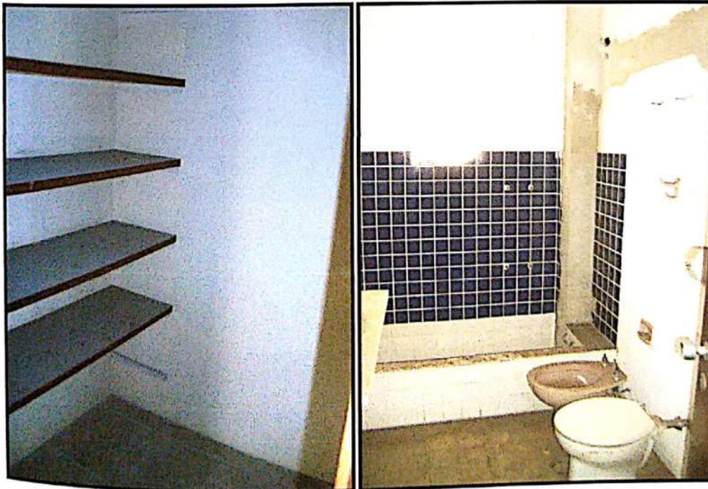
FOTOS 11/13 : Vistas internas da unidade avalianda.
