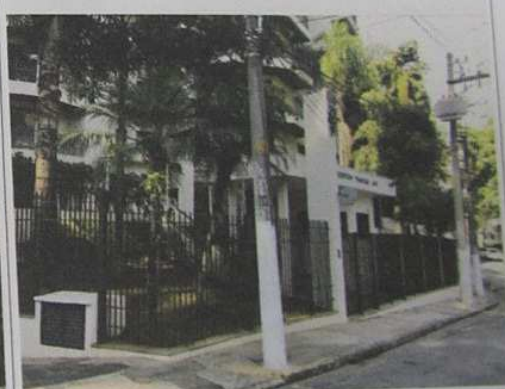
Foto 4: Perspectiva da fachada do Edifício
