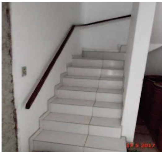
ESCADA INTERNA ACESSO AO PAVIMENTO SUPERIOR
