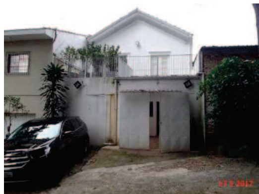
FACHADA VISTA NOS FUNDOS DO IMÓVEL
