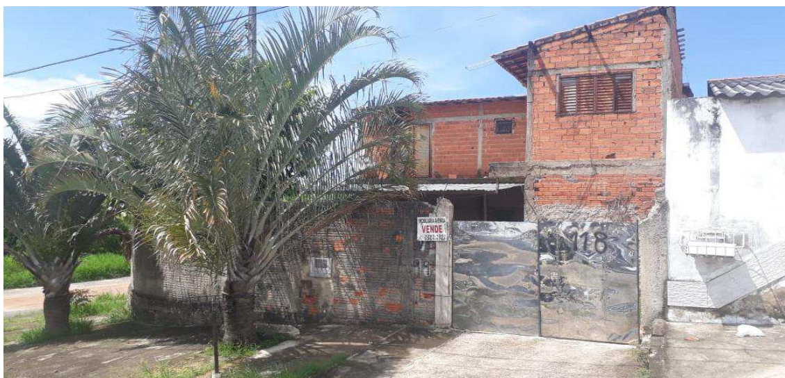
Visão da entrada - Fachada
