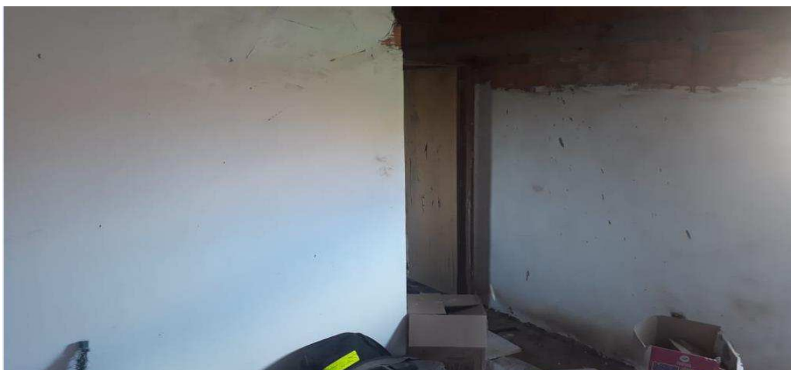
Reboco meia parede
