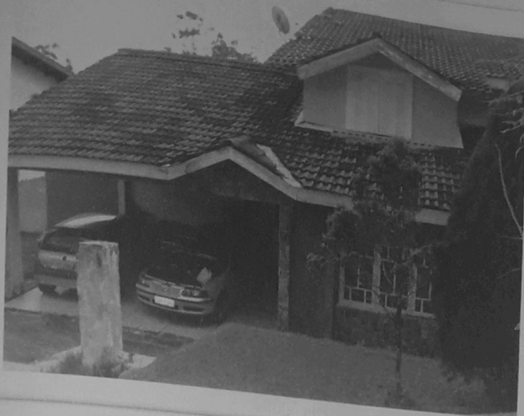
Frente do imóvel avaliando (edícula)
